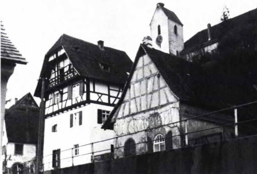
FREIBURG-OPFINGEN. Altes Pfarrhaus.
