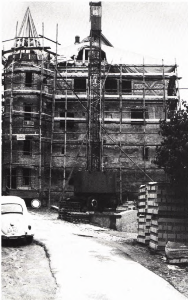
ENGEN. Spendgasse 3, „Hochwacht“.
