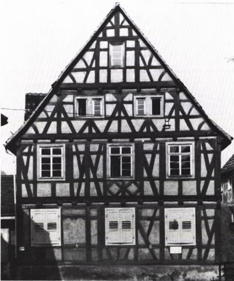
3 DER AMTSKELLER IN ERSINGEN. Im Erdgeschoß der straßenseitigen Giebfassade ist an einem profilierten Sturzriegel ein heute vermauerter Zugang erkennbar.
