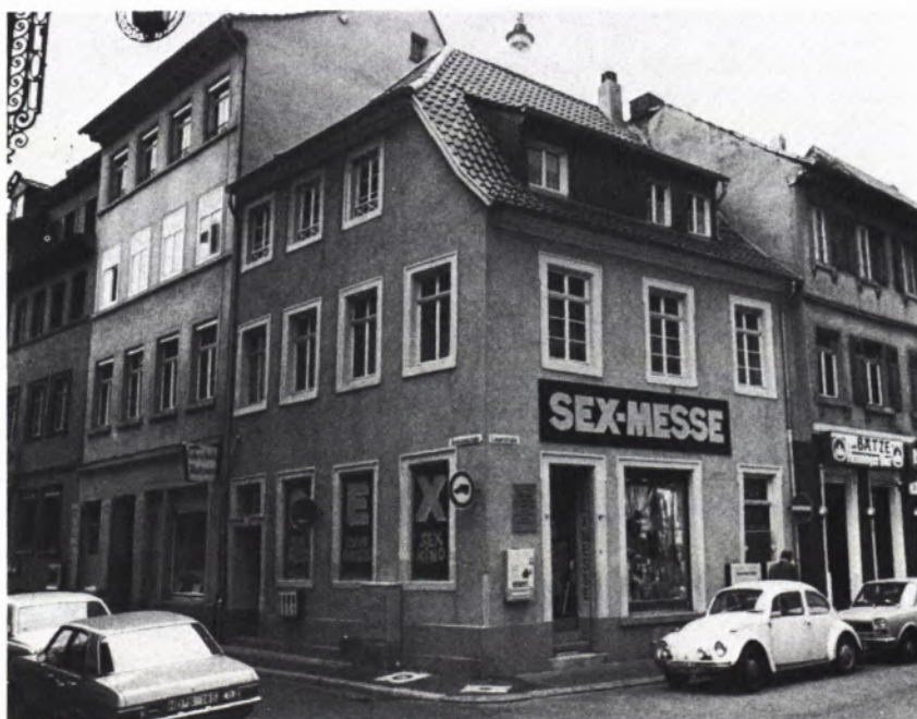
2 HEIDELBERG, DREIKÖNIGS- STRASSE 2. Das Barockhaus mit der ver- unstaltenden Werbeanlage, deren Entfer- nung verlangt wird.
