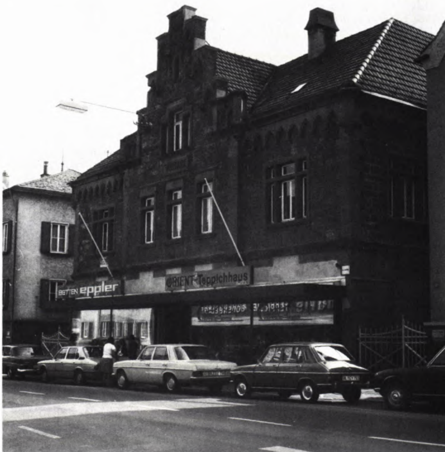
4 NACH DEM ERDGESCHOSSUMBAU, der 1976/77 am ehemaligen Postamt in Balingen vorgenommen wurde und den das Stadtbauamt als „funktionsgerecht, städtebaulich und gestalterisch befriedigend“ bezeichnet.
