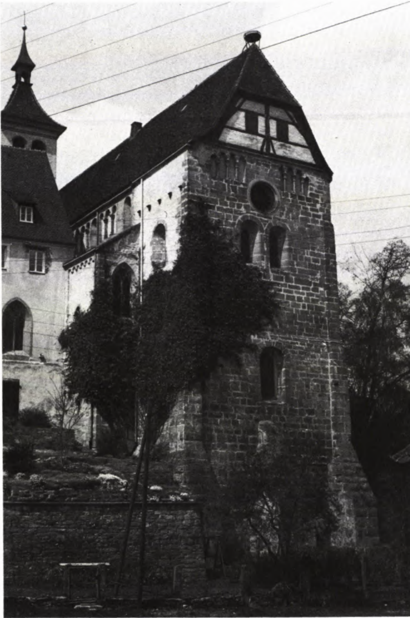
1 DIE KLOSTERKIRCHE DENKENDORF VOR DER RESTAURIERUNG 1963. Deutlich hebt sich vom Großquaderwerk die weniger sorgfältig ausgeführte, verputzte Mauerfläche oben an der südlichen Seite des Chores ab.
