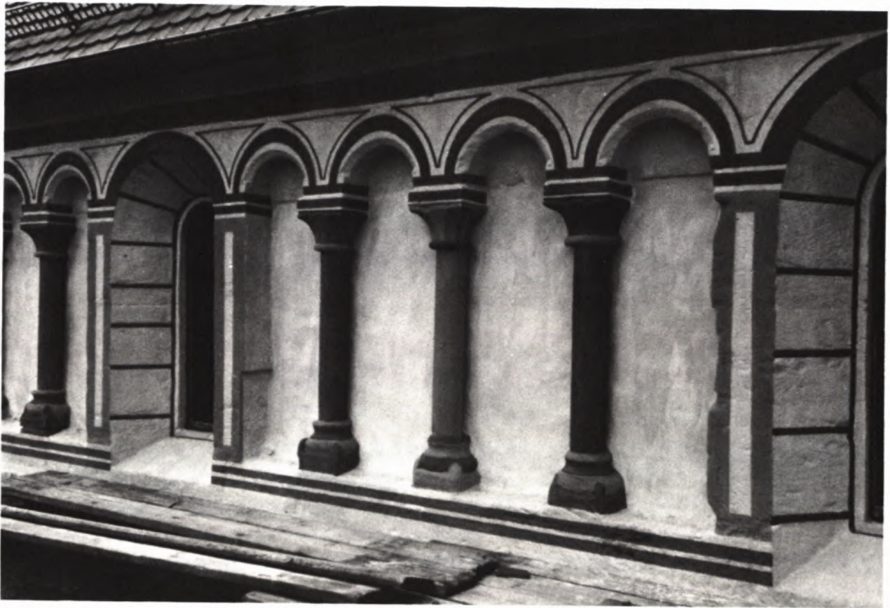
7 NACH DER WIEDERHERSTELLUNG sind die Säulchen der Blendgalerie am nördlichen Obergaden im Wechsel rot und ocker gefaßt.
