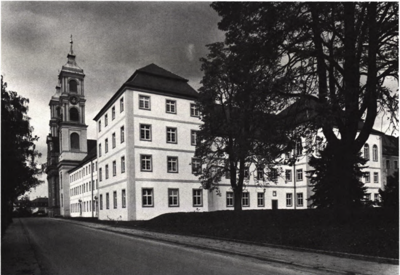
1 BAROCKKLOSTER WEISSENAU von Südwesten. Im Anschluß an die Kirche der instandgesetzte Westflügel, im Vordergrund der Eckpavillon mit der einstigen Prälatur, rechts anschließend der Südflügel mit dem Festsaal im zweiten Obergeschoß des vorspringenden Mittelbaus.
