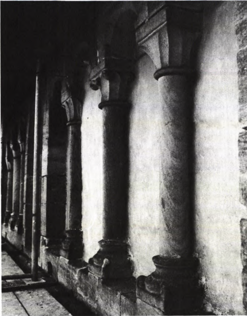
5 BLENDGALERIE am nördlichen Obergaden vor Beginn der Restaurierung.
