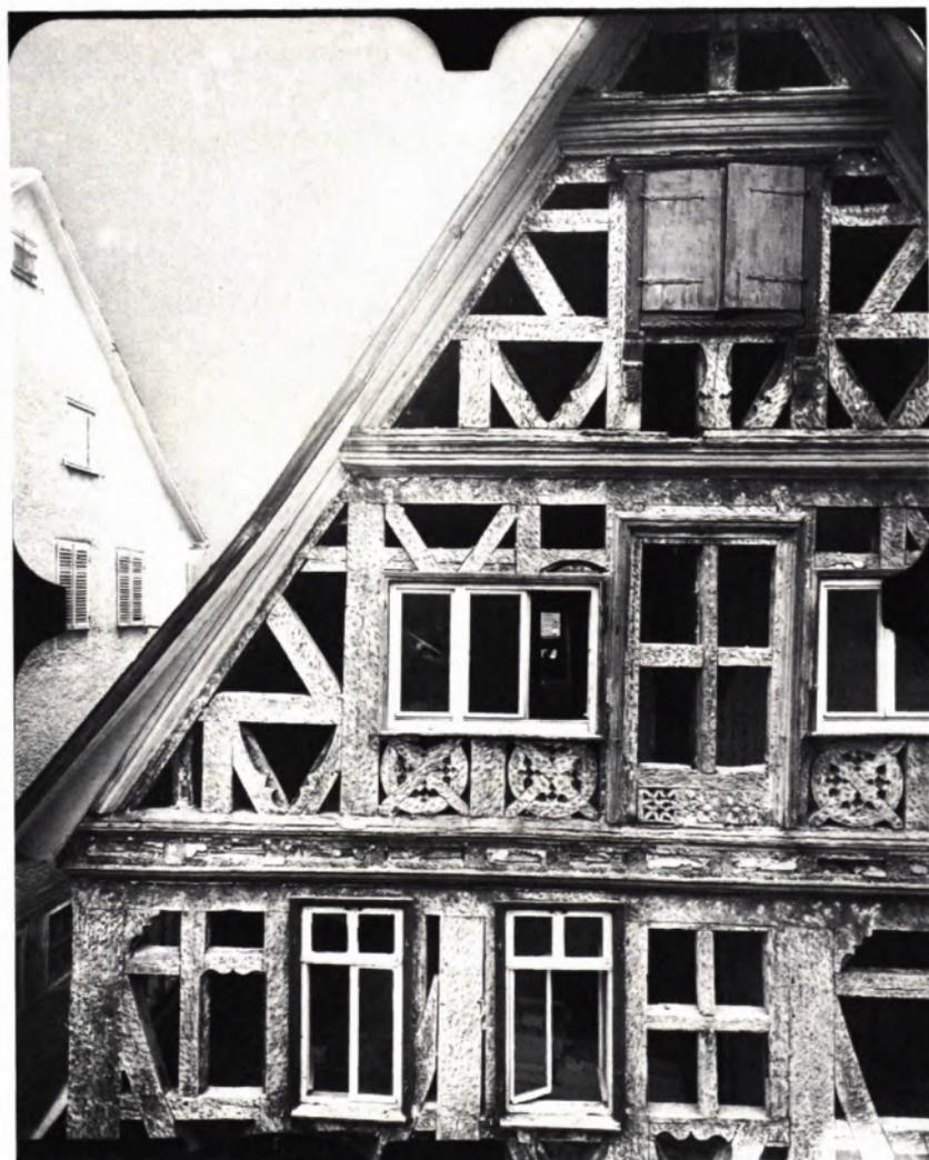
4 DAS FACHWERKSKELETT *nach dem Entfernen der Ausriegelung.*
