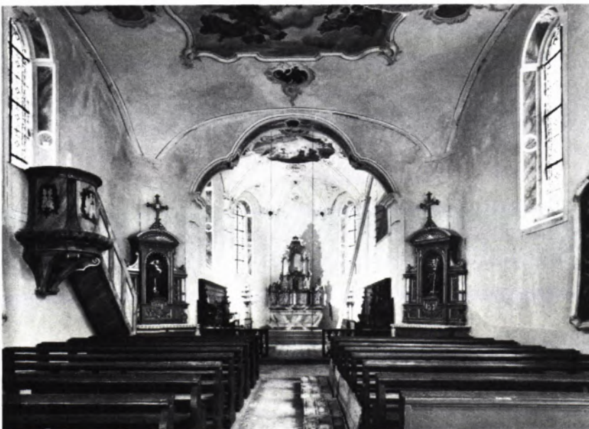
WALLFAHRTSKIRCHE MARIA ZELL IN HECHINGEN-BOLL. Außenansicht von Südwesten und Blick ins Innere gegen Osten.
