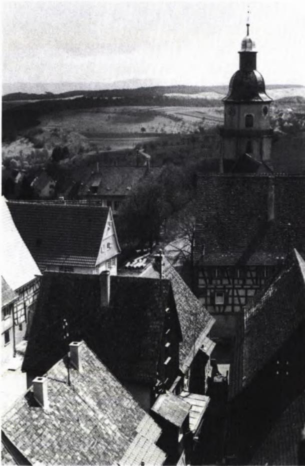
2 BLICK AUF ROSENFELD. Östlicher Teil der Stadt mit Pfarthaus und Kirche.
