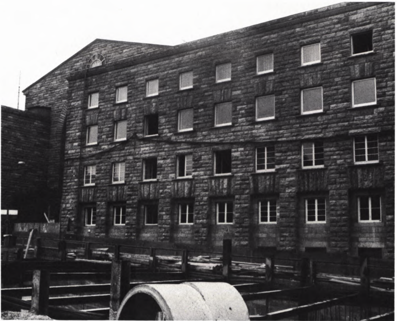
DER HAUPTBAHNHOF IN STUTTGART, Reichsbahnhotel-Flügel, Zustand im August 1976. Die oberen beiden Fensterreihen zeigen die frisch eingesetzten „modernen“ Fenster. In den unteren beiden Fensterreihen sind die originalen Bonatz-Fenster noch erhalten. Bei einigen Fenstern – bei denen mit einfacher Quersprosse – sind die Vorderflügel bereits ausgehängt.
