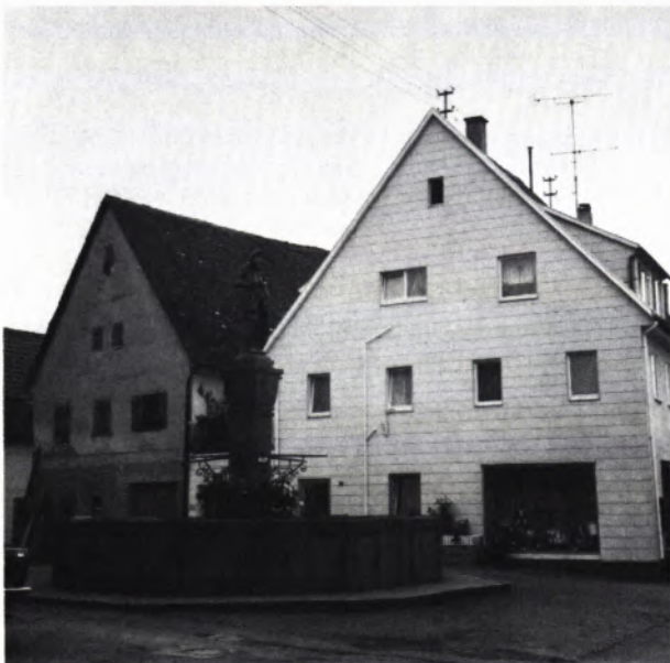
3 MARKTPLATZ mit Renaissancebrunnen und asbestzementverkleidetem Haus.
