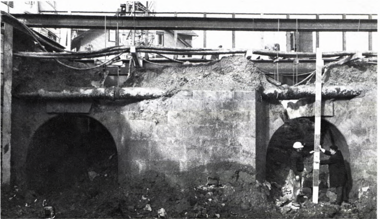
5 DIE VORLANDBRÜCKE WÄHREND DER BAUARBEITEN am 16. Januar 1975. Zu sehen sind gerade die Bögen von 1837, die Bauperiode IV.
