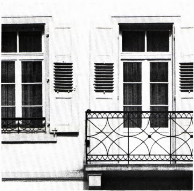
1 und 2 ZWEI SICH GEGENÜBERLIEGENDE FASSADEN, beide aus klassizistischer Zeit, beide mit erneuerten Fenstern. Beim ersten Beispiel ist die Fensterteilung aus der Jahrhundertwende übernommen worden. Durch Wiederherstellung der Klappläden blieb zusätzlich historischer Bezug gewahrt. Balkon- und Fenstergitter liegen filigranartig vor der Hausfront. Beim zweiten Beispiel ist bei der Erneuerung der Fenster auf deren Teilung verzichtet worden, die Fenster bilden Löcher, die erst durch das helle Hervorheben ihrer Gewände erträglich werden. Durch den Verlust weiterer gliedernder Elemente wird so jedoch der Kontrast modisch erhöht, dies aber nicht zugunsten ursprünglicher Aussage.
