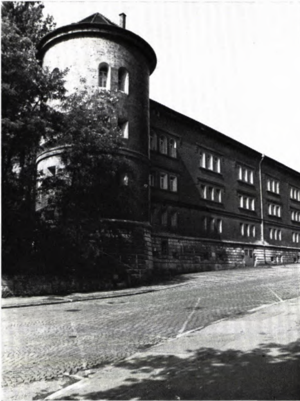
1 und 2 DIE DEFENSIVKASERNE DER OBEREN DONAUBASTION. Auf der Kehlseite gegen die Stadt springt ein runder Flankenturm vor. Die Kasernenfront mit ihren Wohnfenstern ist in den beiden unteren Geschossen aus Juraquadern, in den beiden oberen aus Backstein erbaut. Auf der Verteidigungsseite, einst gegen den Wall gerichtet, steht ein Bestreichungsturm für ein Geschütz vor der Frontmitte. Diese Seite der Kaserne ist in Quaderbauweise errichtet und besaß einst zwei Geschützcharten pro Kasematte.
