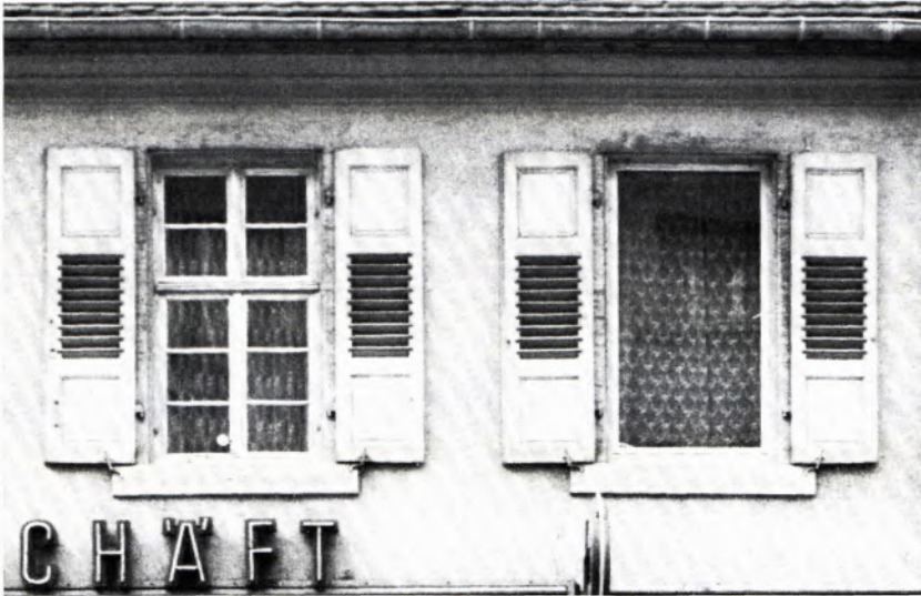
5 ZWEI FENSTER IN EINEM HAUS. Beide haben Sandsteingewände, beide sind mit Klappläden geziert. Eines besteht aus vier Flügeln und zehn Glasflächen, das andere aus einem Flügel und einer Glasfläche. Bei einem ist Wand mit Wand über das Sprossenwerk des Fensters verbunden, beim anderen gähnt an seiner Stelle ein rohbauähnliches Loch.
