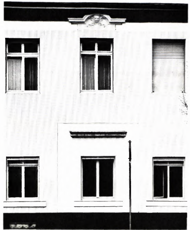
5 ZWEI BENACHBARTE, GLEICH GESTALTETE HÄUSER gegenüber Schloß Rastatt: links die noch halbwegs intakte Barockfassade, rechts was man aus ihr mit einer Metallverkleidung machen kann.
