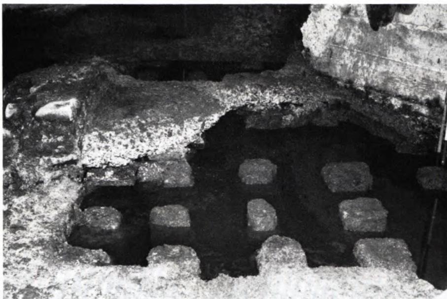
BLICK IN DIE UNTERBODENHEIZUNG VON RAUM A. Nach der Beseitigung der Estrichreste und dem Abpumpen des Grundwassers (vgl. Abbildung oben) traten die sehr kurzstämmigen Kalktuffpfeilerchen der Hypokaustanlage wenigstens zur Hälfte ins Blickfeld.
