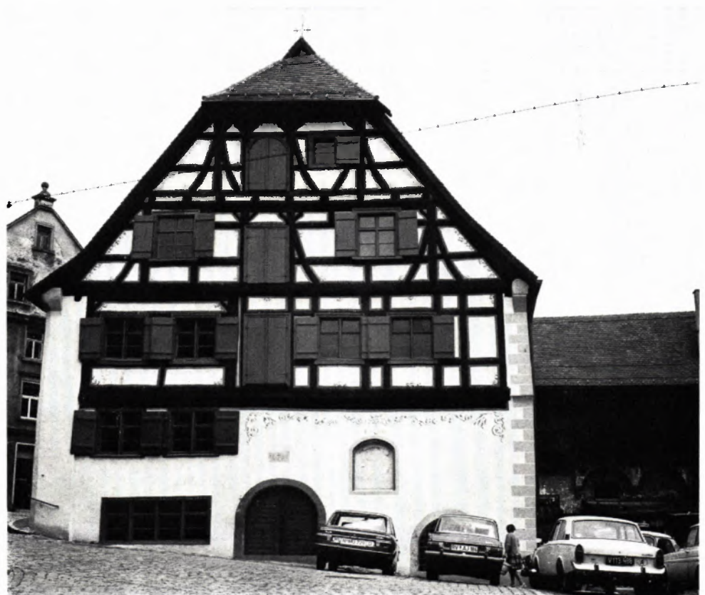
DIE EHEMALIGE STADTMÜHLE VON WANGEN. Das Bild oben zeigt den Zustand des auch Eselsmühle genannten Gebäudes vor (1969) der unten gezeigten, nach denkmalpflegerischen Gesichtspunkten und nach Maßgabe der Baubefunde vorgenommenen Instandsetzung (1974).
