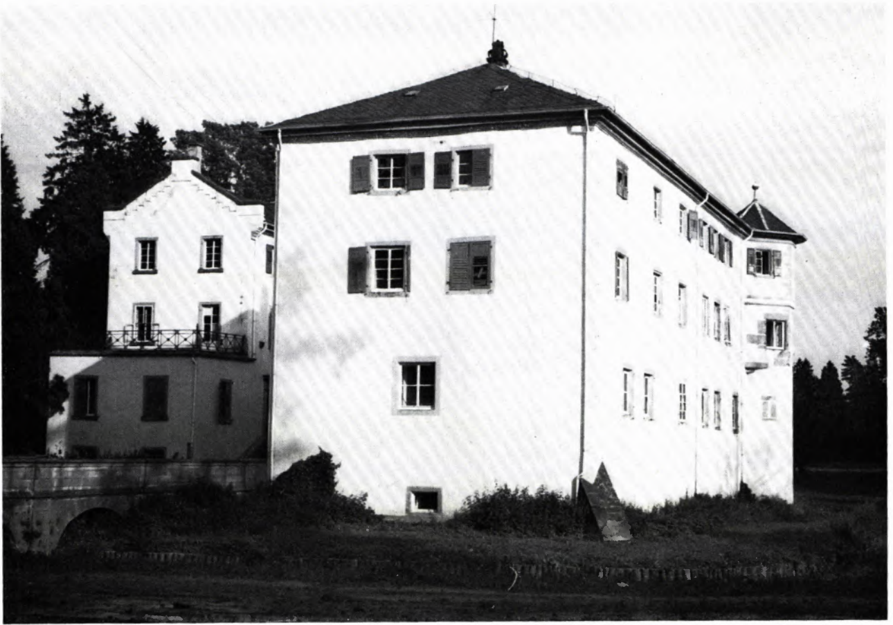
SCHLOSS EICHTERSHEIM. Brücke und verlandeter Graben deuten auf seinen Ausgang von einem Wasserschloß des 16. Jahrhunderts hin. Von diesem sind in der im 18. und 19. Jahrhundert umgebauten Anlage noch einige Teile erhalten, so der im Bild sichtbare Eckturm.
