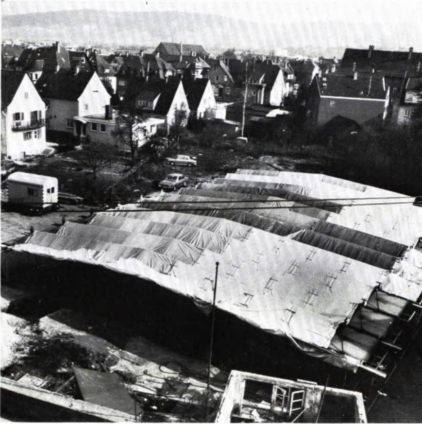
WINTERSCHUTZHALLE ÜBER DEM GRABUNGSAREAL VON 1973/74. Um die Ausgrabung auch über die Wintermonate fortführen und ihre Dauer durch Vermeidung einer winterbedingten Zwangspause abkürzen zu können, wurde die Grabungsfläche mit einer Winterbauhalle überdeckt. Auf der Abbildung unten werden deren 22 Meter lange Dachelemente an Ort gehievt.
