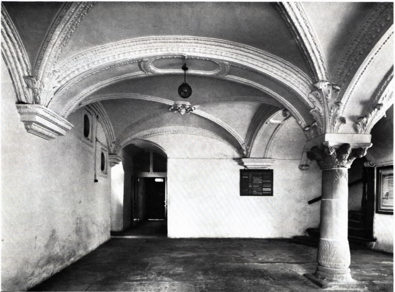
(oben) DIE HALLE IM ERDGESCHOSS. Der quadratische Raum wird von vier durch schwere Gurtbögen getrennte Kreuzgratgewölbe mit aufgesetzten Rippen nach oben hin geschlossen. In der Raummitte tritt eine gedrungene Säule stützend unter das Gewölbe. Ihr Schaft und das Kapitell sind reich geschmückt. Die plastischen Bänder der Rippen und Gurte, die Konsolen und Schlußsteine bilden mit ihrem vielbändigen Stuckdekor einen kräftigen Kontrast zu den völlig zierlos-glatt gehaltenen Wänden. Links der schmale Zugang vom Gebäudeeingang her, rechts der Anlauf der zum Obergeschoß vermittelnden Wendeltreppe.
