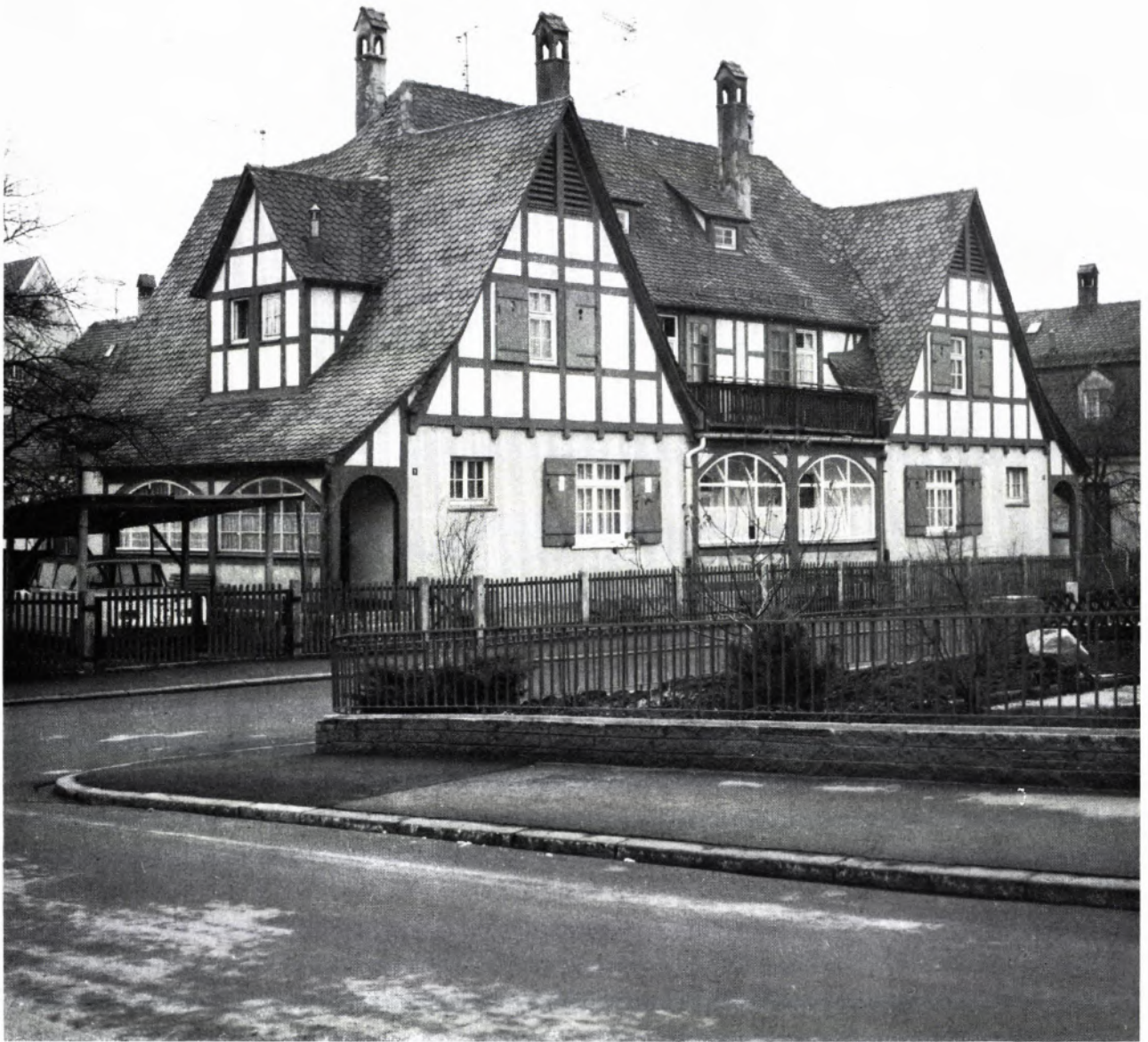
DOPPELWOHNHAUS DES TYPUS 5. Dieser von Fischer 1903 entworfene Haustypus wurde in Gmindersdorf viermal gebaut. Unser Beispiel (Wilhelm-Kuhn-Straße 1/3) hat den alten Bestand sehr gut bewahrt und teilt etwas von der anheimelnden Atmosphäre mit, die den Häusern heute noch anhaftet und nach dem Willen des Architekten gewiß auch zueigen sein sollte.
