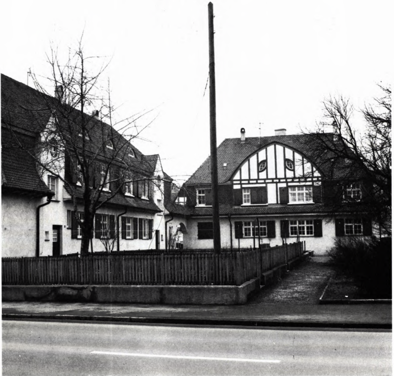
DOPPELWOHNHÄUSER DER TYPEN 15 UND 16. Während der nur einmal gebaute Gebäudetypus 15 (1907; Th.-Fischer-Straße 7/9) trotz aller gegenteiligen Absichten des Architekten in seinem äußeren Erscheinungsbild etwas vom Einschlag einer ländlichen Villa hat, befließigt sich der zweimal verwirklichte Bautypus 16 (links; 1907; Th.-Fischer-Straße 11/15) einer mehr nüchternen Haltung.
