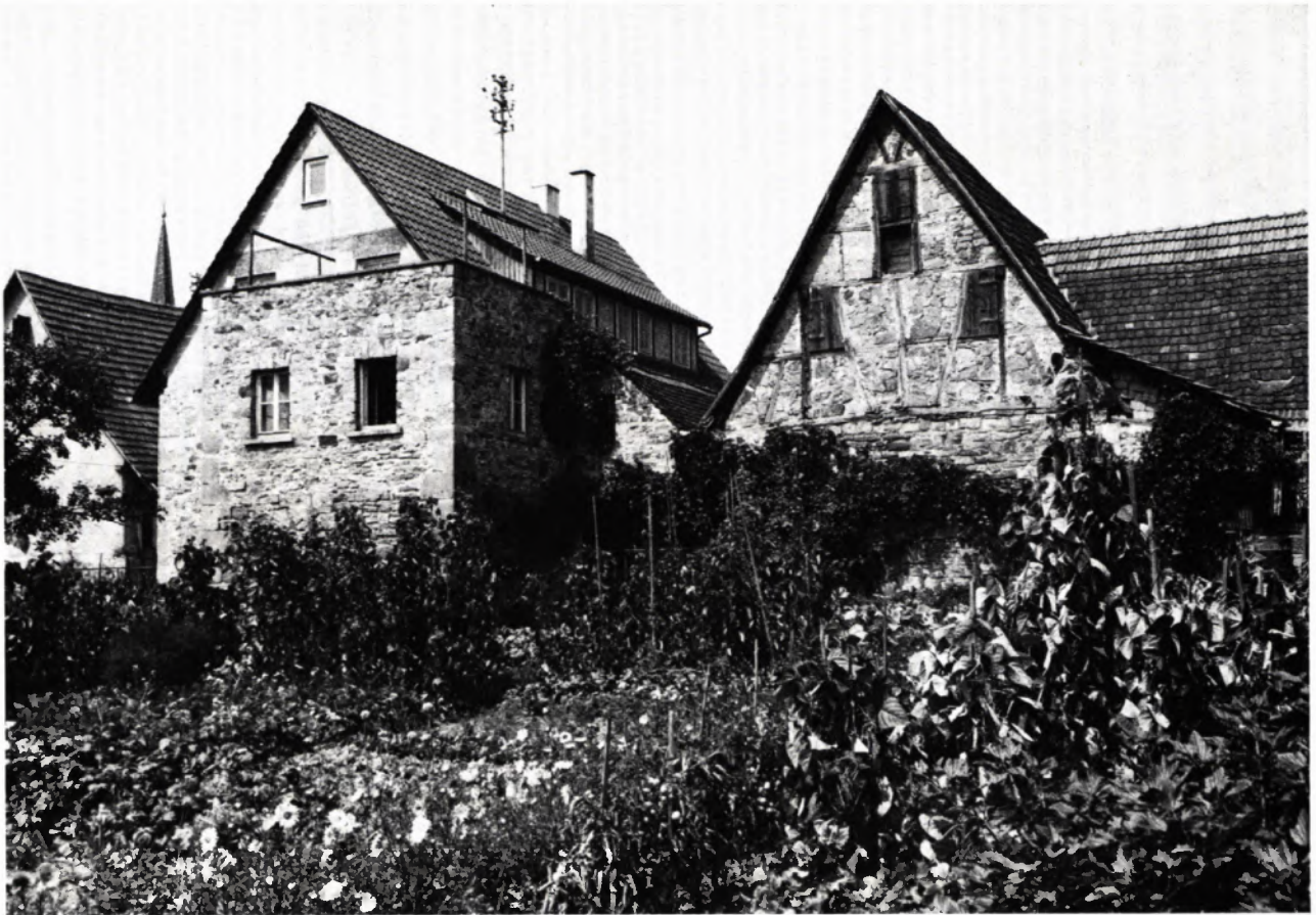
RELIKTE VOM SÜDZUG DER GRÖTZINGER STADTMAUER. Die Reste des Stadtmauerturmes und der Wehrmauer haben ihr Überdauern hier der Verwendung zu Wohnzwecken bzw. als Außenmauer einer Scheune zu danken.
