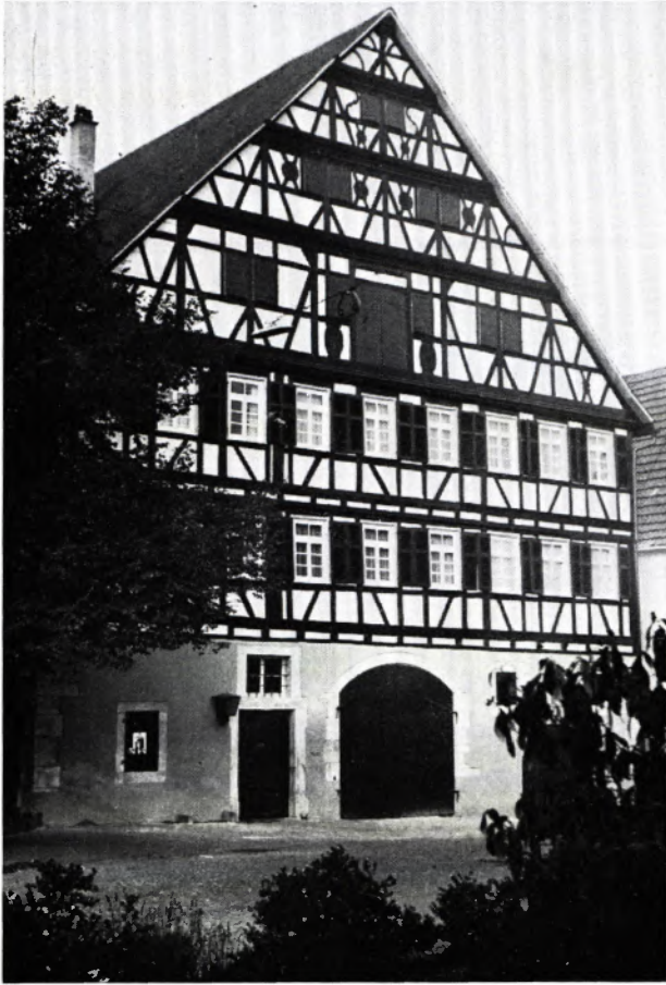
DAS EVANGELISCHE PFARRHAUS IN GRÖTZINGEN. Nach einer Inschrift am Giebel 1683 (vom Kirchheimer Spital) erbaut, ist das lobenswerterweise schon eingangs dieses Jahrhunderts von seinem Putzmantel befreite stattliche Gebäude das eindrucksvollste unter den in Grötzingen erhaltenen Fachwerkhäusern. Besonderes Augenmerk verdient der mächtige, in vier Geschossen sich aufbauende Giebel, dessen Holzwerk durch geschwungene Streben und geschnitzte Zierscheiben bereichert ist.
