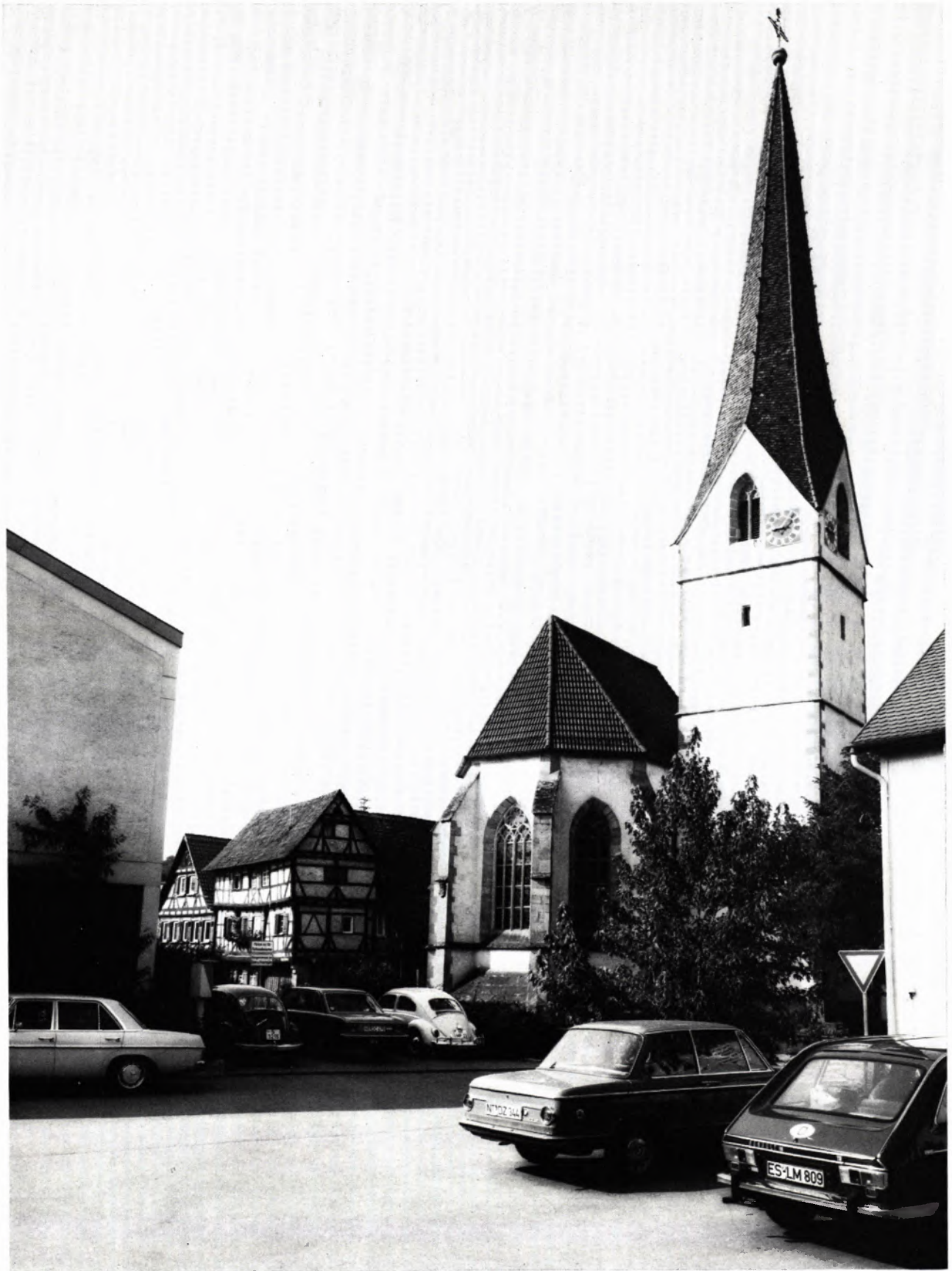
BLICK VON NORDOSTEN AUF KIRCHE UND ALTES SCHULHAUS IN GRÖTZINGEN. Die ursprünglich dem Hl. Otmar geweihte Kirche mit ihrem spätgotischen Chor (1456) und dem die weithin sichtbare Mitte des Ortes bildenden steil aufragenden Turm (in den unteren Teilen 13./14. Jahrhundert) wurde 1967/68 gründlich renoviert. Dabei wurden Überreste eines womöglich ins 9./10. Jahrhundert zurückgehenden Vorgängerbaues angeschnitten und auf den Innenwänden qualitätvolle Fresken aus der ersten Hälfte des 14. Jahrhunderts entdeckt. Das Fachwerk des Alten Schulhauses (links; 16. Jahrhundert) harret noch einer durchgreifenden Renovierung.
