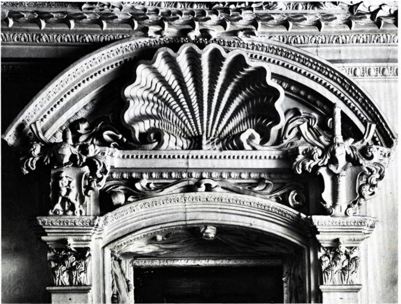
STUCKAUFSATZ ÜBER EINER TÜR DER TREPPENHAUSHALLE DES ZWEITEN OBERGESCHOSSES. Die kraftvolle Plastizität und der formale Reichtum der Stukkaturen in der Treppenhaushalle des zweiten Obergeschosses (vgl. Abb. S. 8) werden an diesem Detail besonders deutlich. Links über der Kapitelldeckplatte des türrahmenden Pilasters das Wappen der Familie Albrecht, rechts das der Familie Wachter.
