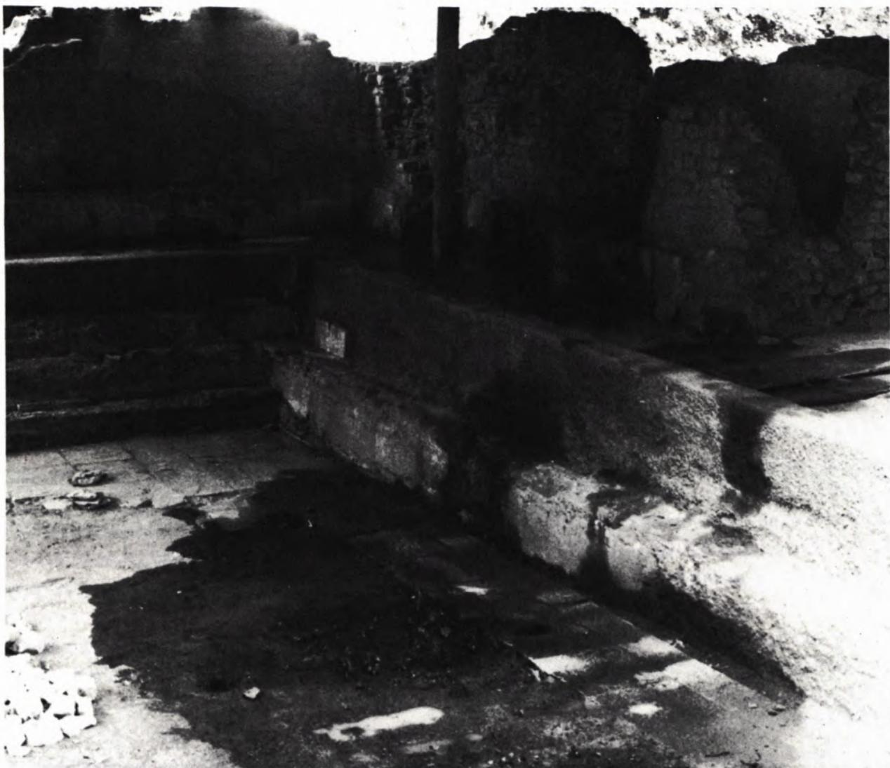
4 DER WESTLICHE BADESAAL, Zustand Ende August 1979. Deutlich erkennbar sind die dunklen, völlig durchnässten Stellen. Im Vordergrund in der Bildmitte sowie hinten beim Stahlträger steht das Wasser einen bis zwei Zentimeter hoch.
