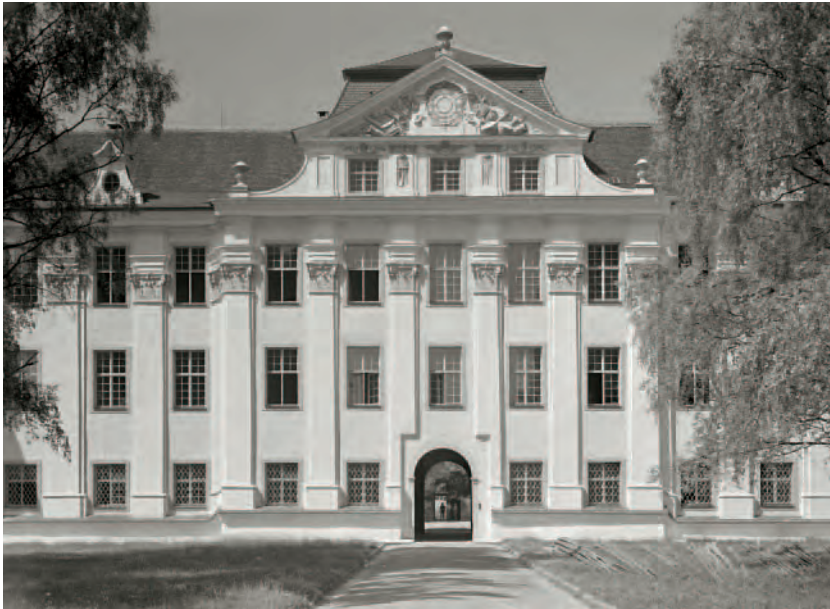
4 Die Nordostfassade um 1953 mit neuen Fenstergewänden.
