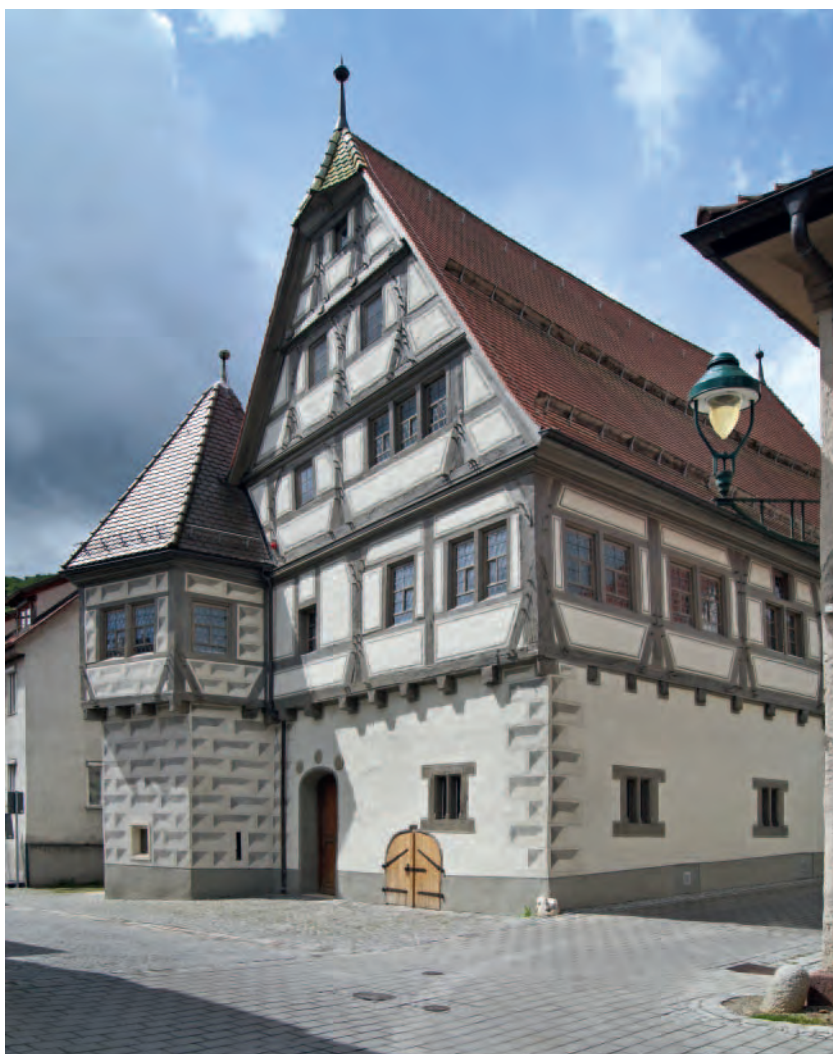
3 Fachwerkhaus in der Webergasse 11 in Blaubeuren mit Quaderbemalung an Turmanbau und Gebäudeecke.
