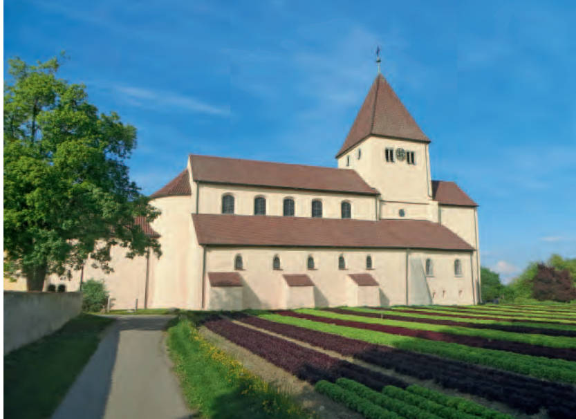
2 St. Georg in Oberzell, Außenansicht von Süden im April 2014.
