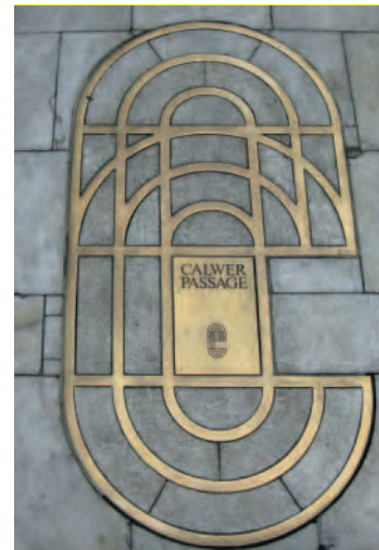
5 Zugang von der Theodor-Heuss-Straße mit intarsiertem Fußbodenbelag.
