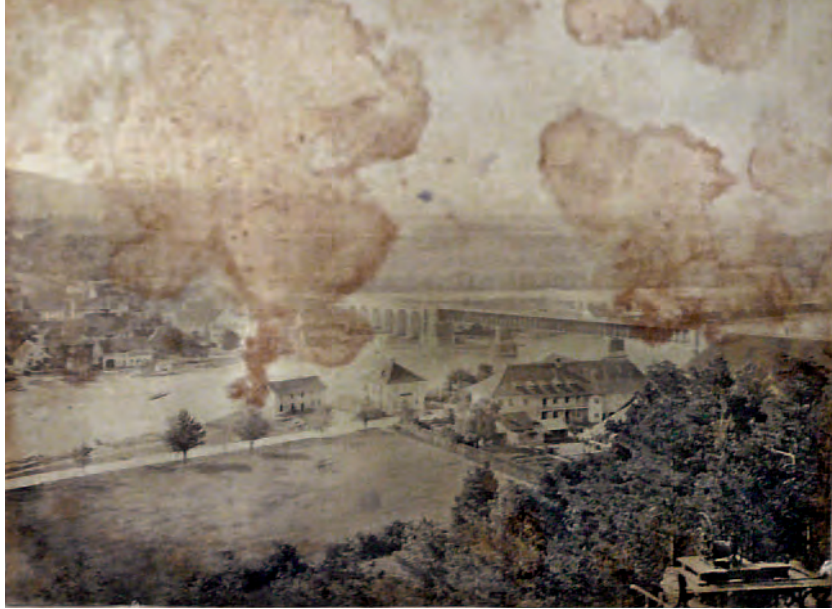
3 Blick aus Waldshut auf die fertige Brücke ohne Gerüste – nach dem 18. August 1859.
