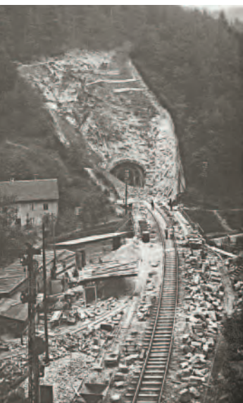
7 Bauarbeiten beim Großen Triberger Kehrtunnel im Sommer 1930.
