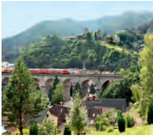
Das Hornberger Viadukt im Schwarzwald. (Foto: Foto Carle, Triberg)
