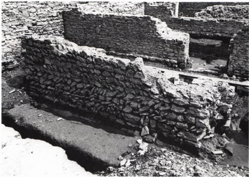
5 BRUCHSAL, ehem. Burg der Bischöfe von Speyer; Mauerrest im Fischgrätenverband ( opus spicatum ) in der Außenschale.
