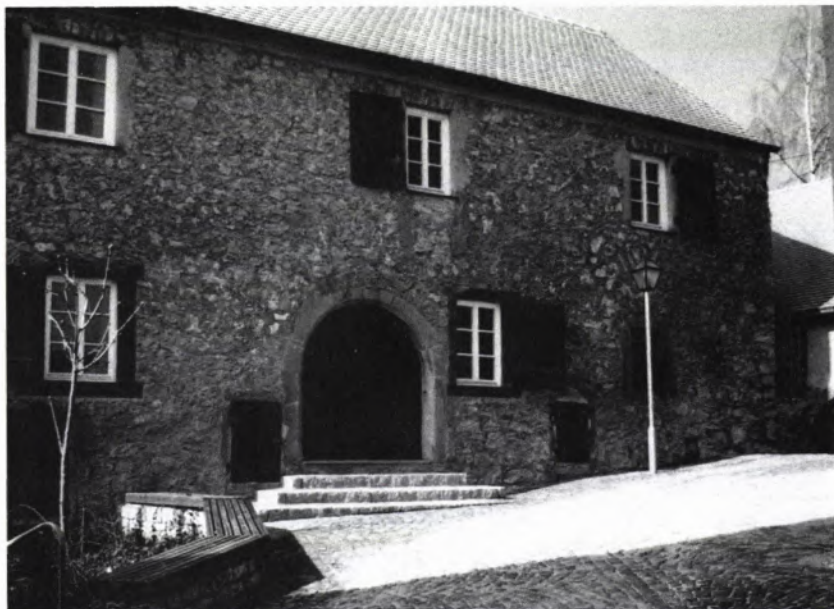
10 HERRENHAUS nach der Instandsetzung. Heute ist es Gemeinschaftshaus der Gemeinde.
