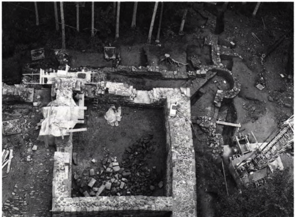
11 RUINE MAND- DELBERG bei Bösin- gen, Gde. Pfalzgraf- weiler, Kr. Freudenstadt; Blick auf den teilweise gesicherten Palas und noch ungesicherte Teile der Vorburg. Es wurde versucht, den Charakter des Mauerwerks zu zei- gen, wengleich der Ab- schluß noch etwas zu re- gelmäßig wirkt, Zustand 1982.
