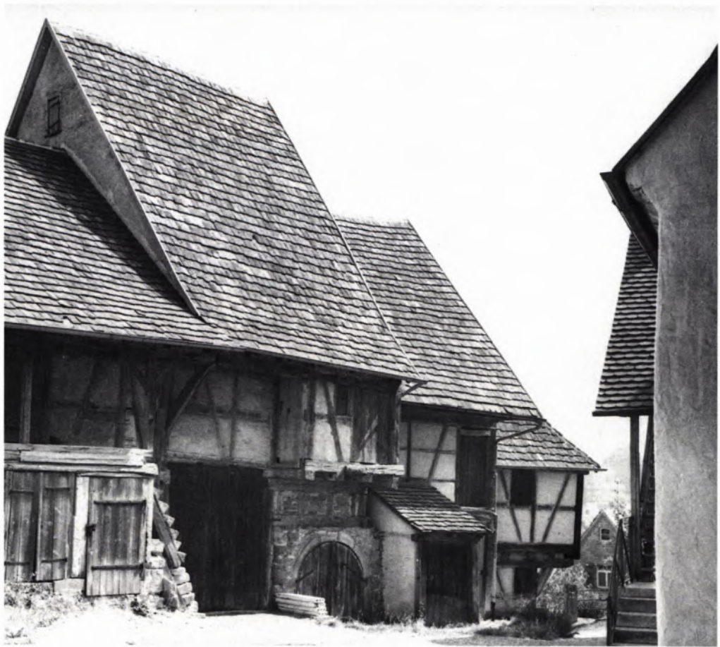
7 VORHER: Gaden mit alter Blocktreppe vor der Instandsetzung.
