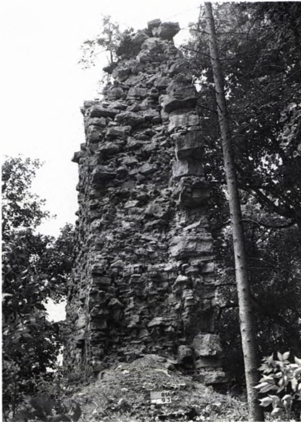
4 DIE SCHILDMAUER der Ruine Frundeck bei Horb-Ahldorf, Kr. Freudenstadt, mit besonders großen Steinblöcken in der feindseitigen Außenschale, ist bereits in voller Auflösung begriffen. Dies zeigen die überhängenden Steine ebenso wie der Schuttkegel am Fuße der Mauer und die herausbröselnde Zwischenfüllung.
