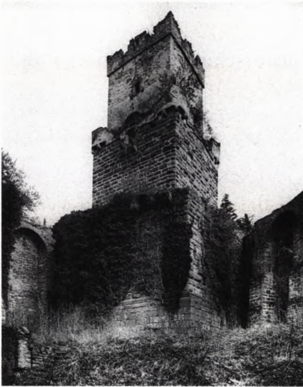
15 FREUDENBERG, Aufnahme von 1983. Der untere Teil des Turmes ist von Efeu überwuchert. Die Zinnen auf den Schildmauern sind nicht mehr erkennbar. Nur von der Mauerkrone aus lassen sich Reste des Wehrganges nachweisen.
