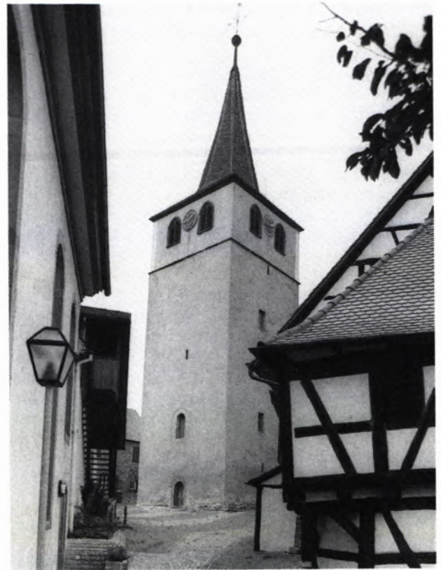
4 DER TURM, ehemaliger Bergfried der Anlage.
