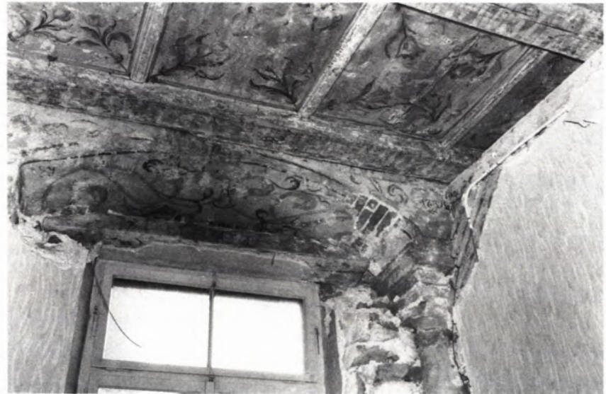
11 AUSMALUNG im hofseitigen Raum des 1. Obergeschosses im Haus Salzstraße 22. Rechts im Bild die nachträglich eingezogene Trennwand; über dem Kapitell der Renaissancesäule die Datierung 1739.
