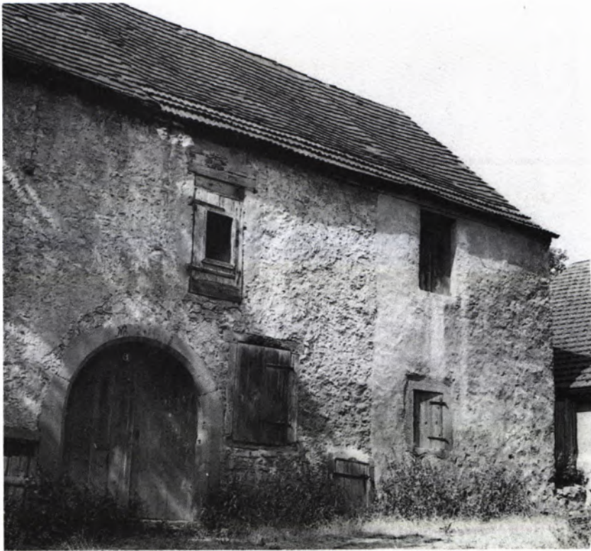
9 HERRENHAUS, Hofseite vor der Instandsetzung. Es diente als Speicher.
