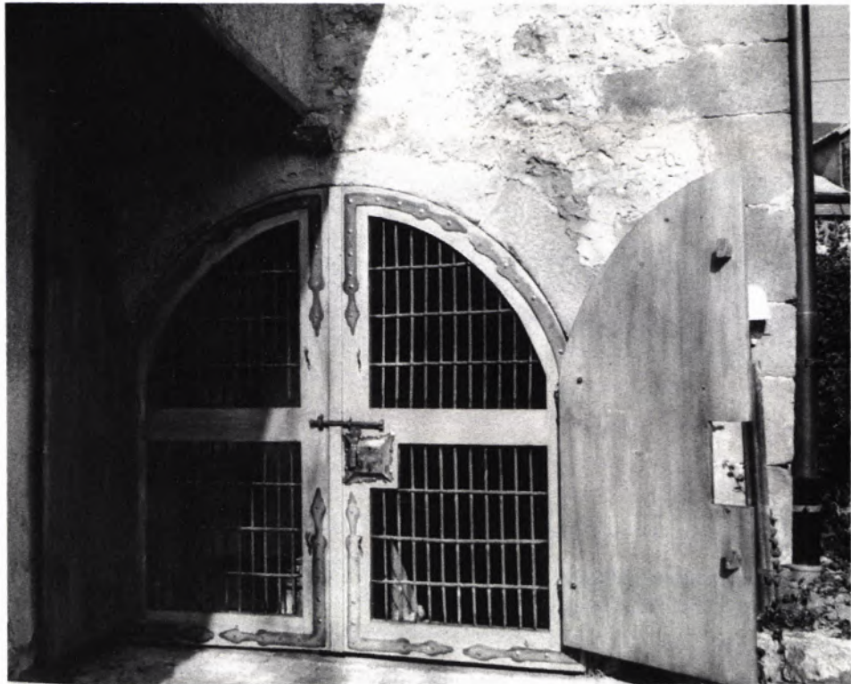
11 DAS TOR zum Keller unter dem Herrenhaus nach der Instandsetzung.
