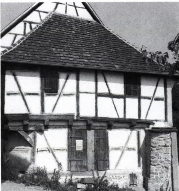
5 EIN GADEN der Wehrkirchenanlage.
