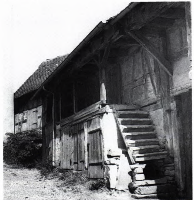
6 GADEN gegenüber der Nordseite der Kirche vor der Instandsetzung.
