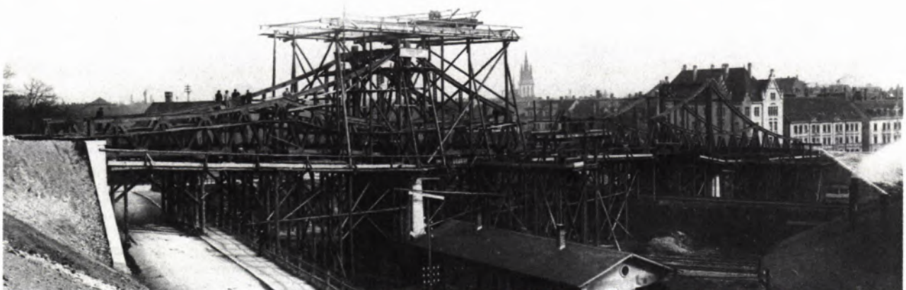
2 DIE BRÜCKE IM BAU 1906/07.
