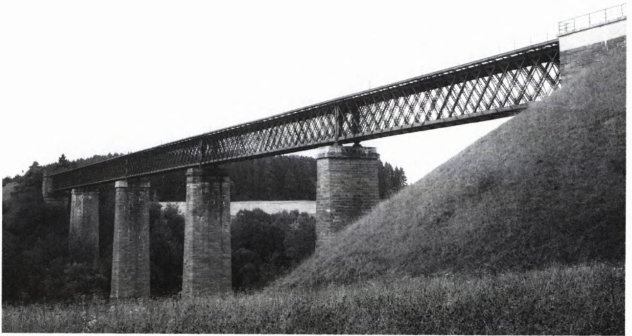
8 KÜBELBACH – VIADUKT BEI DORNSTETTEN, erbaut 1875/79 (1985).
