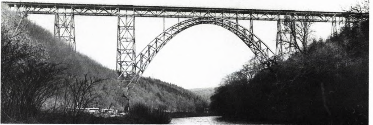
9 DIE EISENBAHNBRÜCKE ÜBER DIE WUPPER BEI MÜNGSTEN, erbaut 1893–1897.
