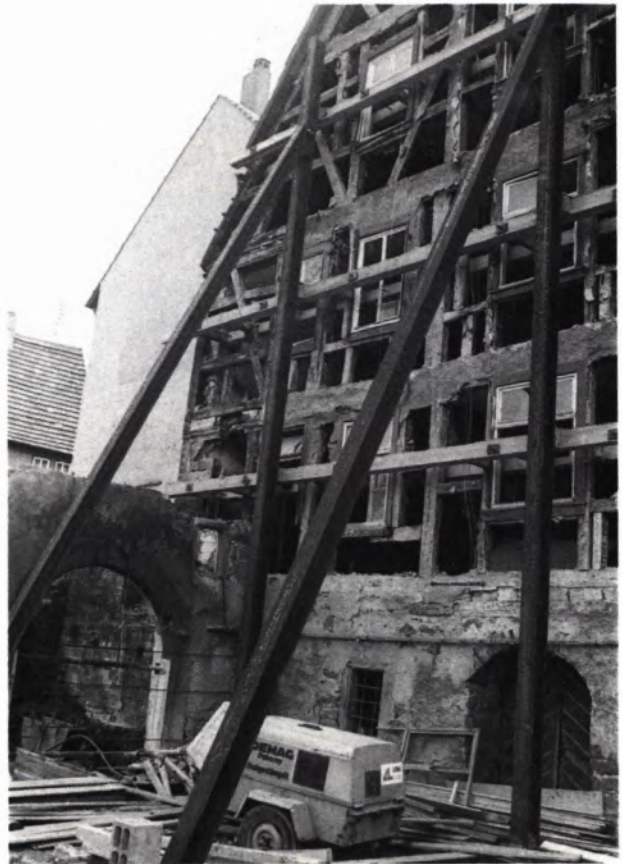
4 GASTHAUS „ZUM RIESEN“ während der Sanierung, 1984.
