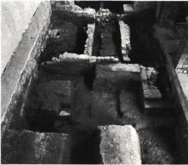
13 ZUGANGSSTOLLEN und jüngerer Zugang zur Krypta, von Westen.
