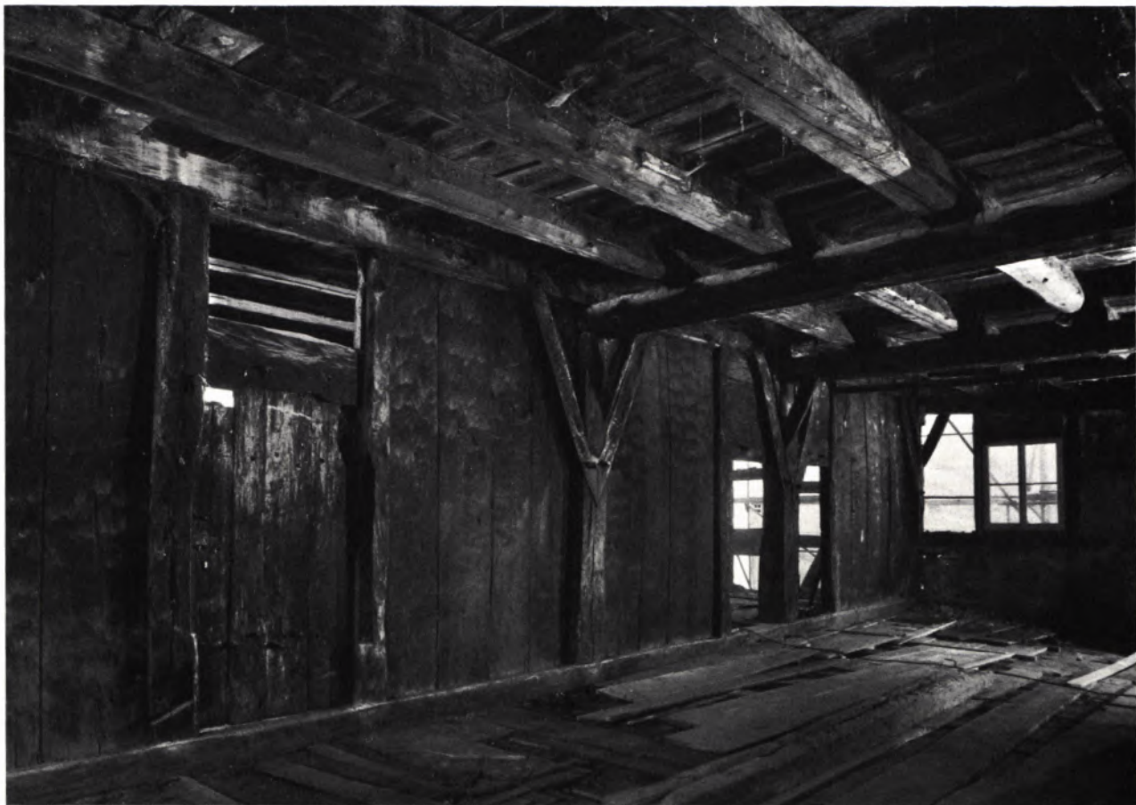
7 ORIGINALA BRETTERWAND im 2. OG mit Brettüre, die ohne jegliche Eisenteile konstruiert ist. Die Kopfbänder in Querrichtung an den Innenstützen setzen tief an, um eine Anblattung der Kopfbänder in Längsrichtung zu ermöglichen.
