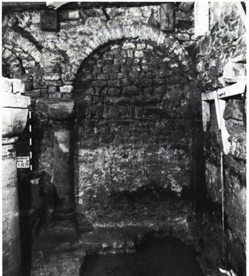
9 SÜDLICHES BOGENFELD der Ostwand in der Krypta mit Resten des Wandputzes im unteren Bereich.
