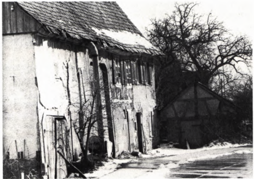
1 BAUERNHAUS in Rottweil-Hausen. Zustand 1979.
