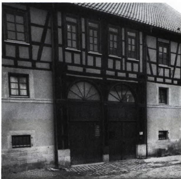
8 KÖNIGEN. Die ehem. Mühle wurde 1843 als verputztes Fachwerkgebäude errichtet. Falsch verstandene Fachwerkromantik und Werbegründe führten zur Freilegung des belanglosen, rein konstruktiven Fachwerks. Der Risalit mit dem Doppelportal ist kaum mehr ablesbar; die Spannung zwischen Pfeilern, Putzfläche und in die Fläche eingeschnittenen Bögen ging verloren.
