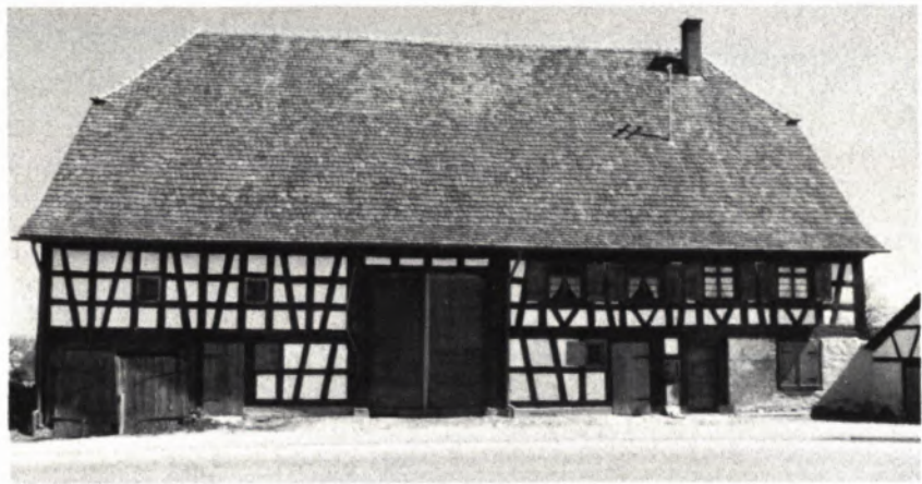
2 DAS GLEICHE HAUS nach seiner Fertigstellung 1980.
