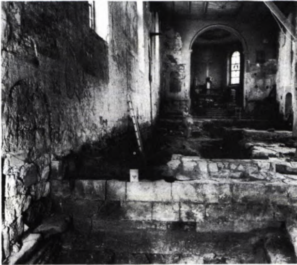
2 KIRCHDORF, St. Martin. Photogrammetrische Aufnahme für die Dokumentation der Ausgrabungen im Kircheninneren. Die Meßaufnahme erfaßt die im Vordergrund sichtbare innere Westfassade des 12. Jh. Das Bild zeigt in der Perspektive die nördliche Innenwand mit der ehemaligen Eingangstür zur Vorhalle und schematisch die freigelegten Fresken.
