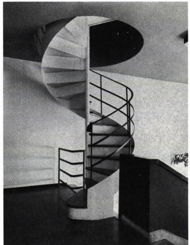
14 WENDELSTREPPEN zur Dachterrasse des Treppenturms.
