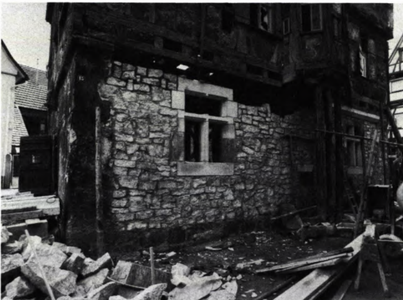
4 NEUES MAUERWERK im Erdgeschoß.
