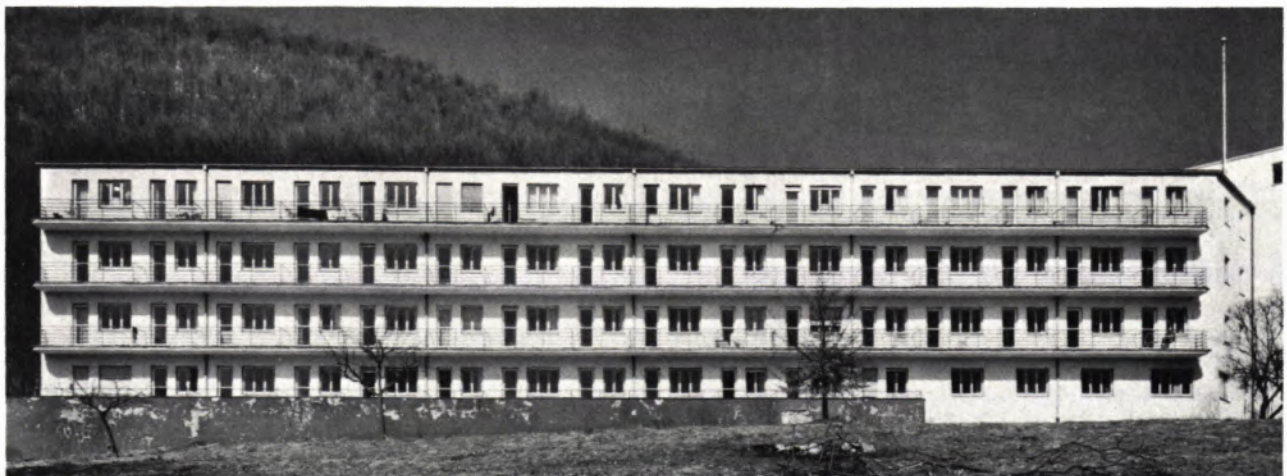
5 GÄSTETRAKT mit Balkonen in der gesamten Länge des Baukörpers und mit regelmäßigem Wechsel von zwei- und dreiflügeligen Fenstern (Ein- und Zweibettzimmer).
