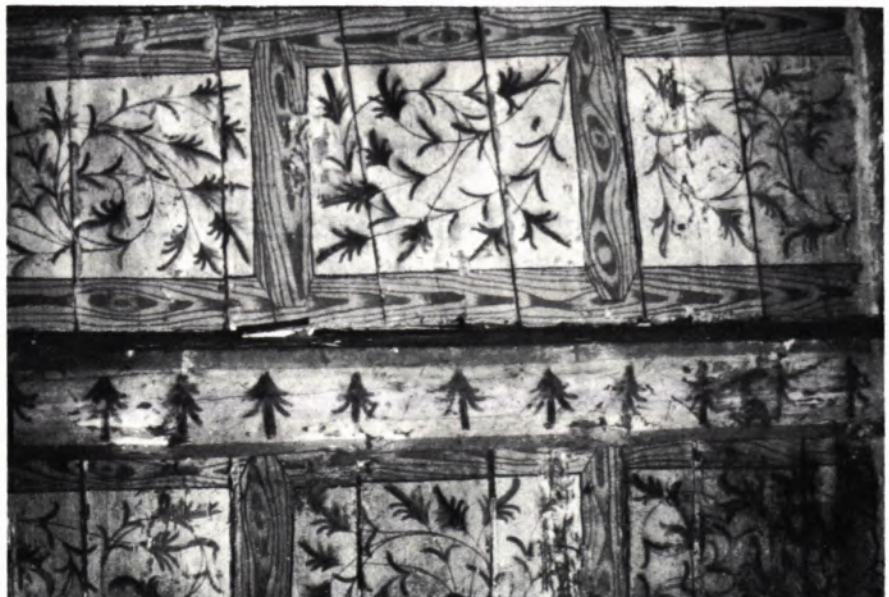
9 DECKE DES WOHNRAUMES. Die reich bemalte Holzdecke von 1535 konnte in letzter Stunde noch geborgen werden.
