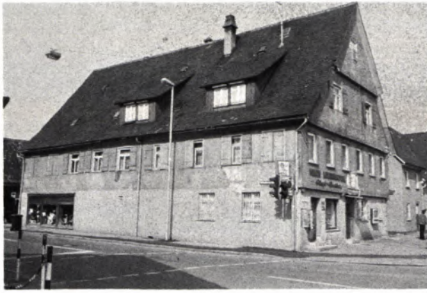
4 und 5 SÜSSEN. Hauptstraße 42 vor der Renovierung. Die Fenster haben ihre Gliederung, Halbfutter und Bekleidung und ihre Fensterläden verloren. Am verdeckten Putz sind Spuren der Fachwerkuntersuchung erkennbar.
