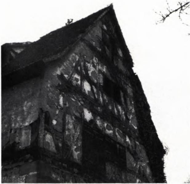
11 und 12 NECKARTAILFINGEN, ehem. Zehntscheuer des Tübinger Stiftes. Das Sichtfachwerk aus der 1. Hälfte des 18. Jh. wurde wohl noch im 18. Jh. verputzt und erhielt eine farbliche Gestaltung: ockerfarbene Gesimse und perspektivische Kantenquader mit roten Randlinien und rot-weiß-schwarzen Fugen. Die Besonderheit dieser Gestaltung verlangt eine Rekonstruktion, aber keine Fachwerkfreilegung.
