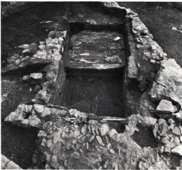
10 KALKGRUBE mit den gut erhaltenen Bohlen der Holzverschalung.
