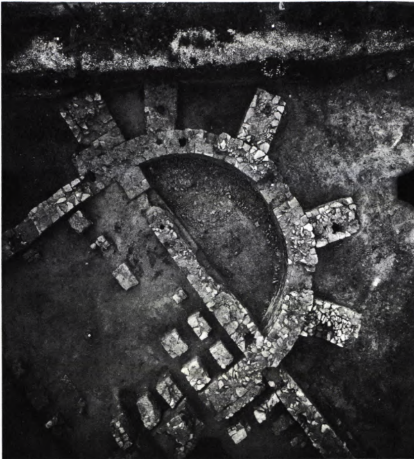
3 DIE APSIS im Südwesten des Bades mit den Fundamenten von fünf Strebe-pfeilern.
