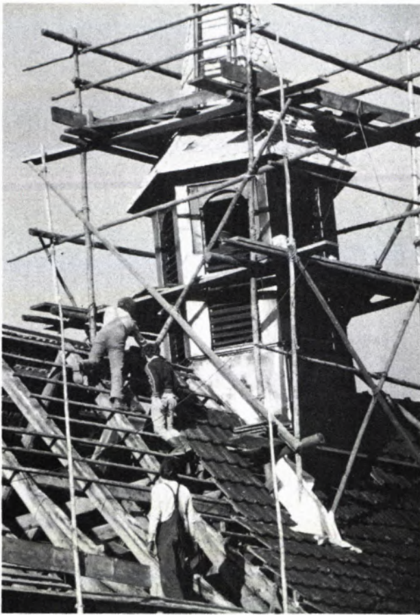
3 NECKARBURGKAPELLE bei Rottweil. Mitglieder der Jugendgruppe bei Dacharbeiten.
