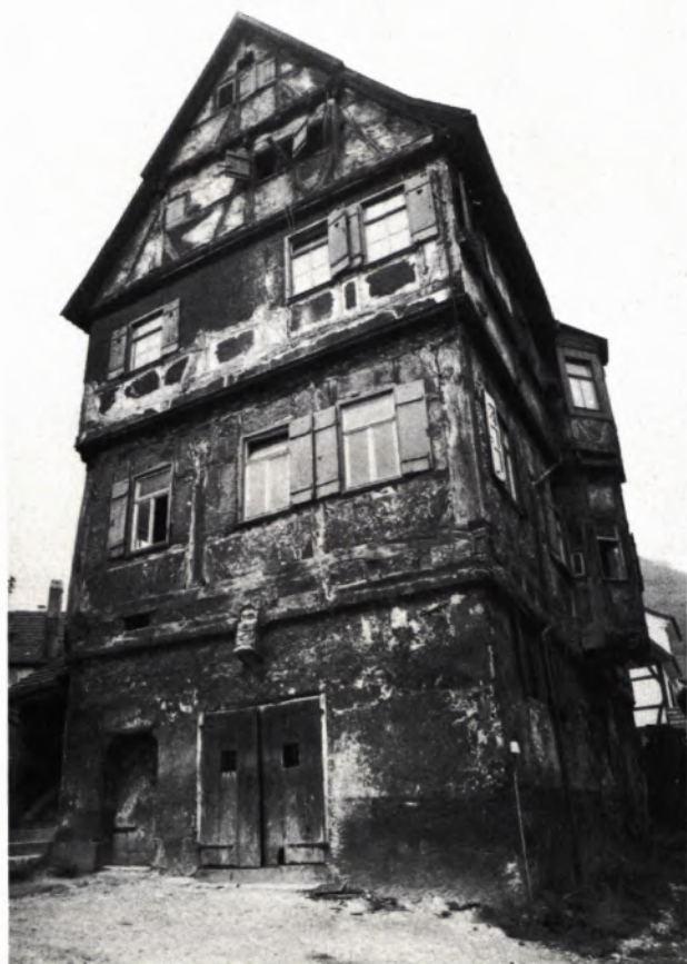
1 HAUS AM GORISBRUNNEN, vor Beginn der Baumaßnahmen.
