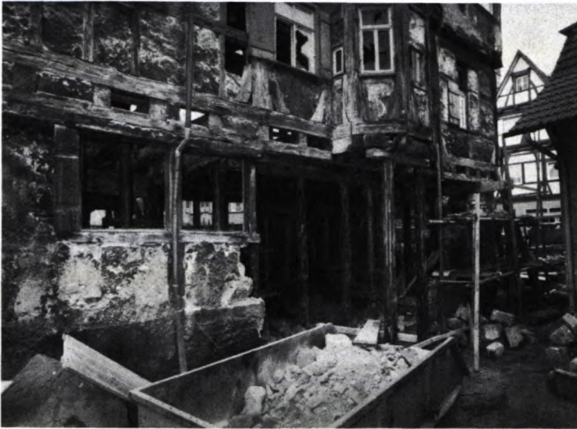
3 ERDGESCHOSS während der Ab-sprieß- und Erneuerungsarbeiten.
