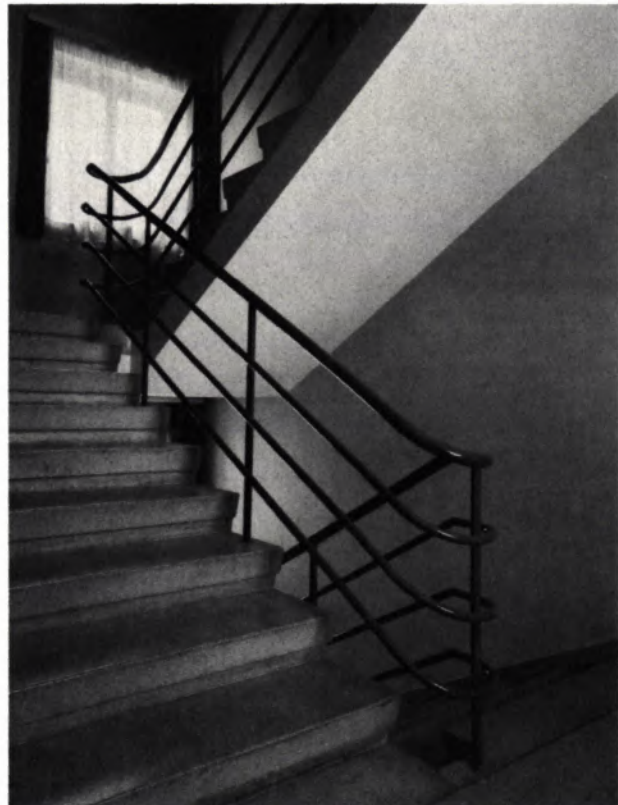
15 TREPPENHAUS im Gästetrakt mit dem für die Formgebung des Neuen Bauens charakteristischen Stahlrohrgeländer.
