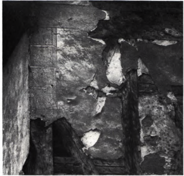
11 und 12 NECKARTAILFINGEN, ehem. Zehntscheuer des Tübinger Stiftes. Das Sichtfachwerk aus der 1. Hälfte des 18. Jh. wurde wohl noch im 18. Jh. verputzt und erhielt eine farbliche Gestaltung: ockerfarbene Gesimse und perspektivische Kantenquader mit roten Randlinien und rot-weiß-schwarzen Fugen. Die Besonderheit dieser Gestaltung verlangt eine Rekonstruktion, aber keine Fachwerkfreilegung.
