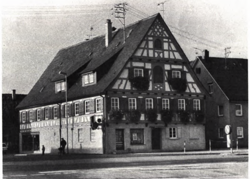
4 und 5 SÜSSEN. Hauptstraße 42 vor der Renovierung. Die Fenster haben ihre Gliederung, Halbfutter und Bekleidung und ihre Fensterläden verloren. Am verdeckten Putz sind Spuren der Fachwerkuntersuchung erkennbar.
