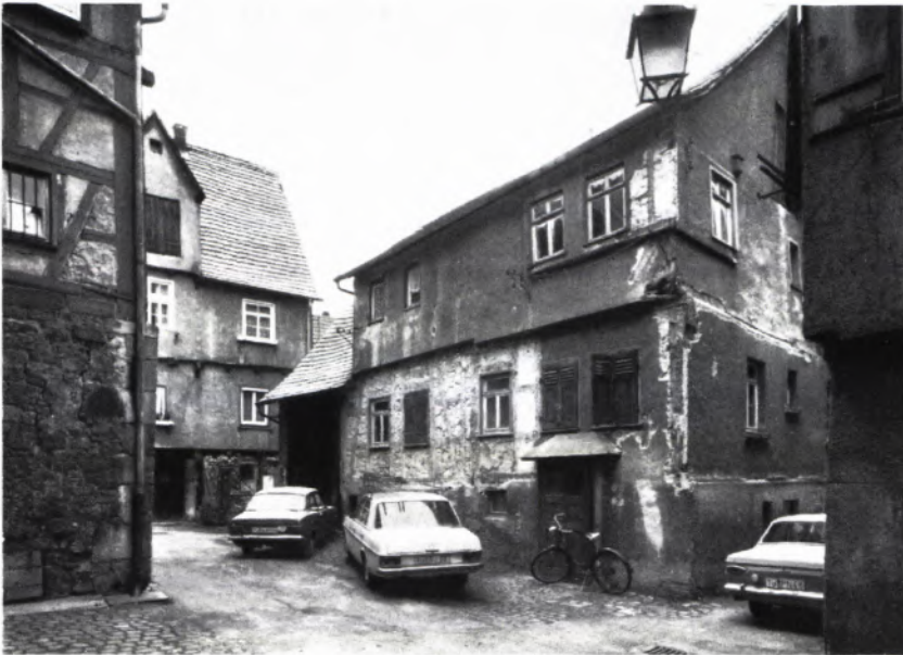
6 HAUS JUDENGASSE 5 (Mitte) „Im Süßen Löchle“. Bei der einseitigen Aufstockung im Obergeschoß hat sich der Fenstererker noch erhalten. Versuch einer „erhaltenden Sanierung“.
