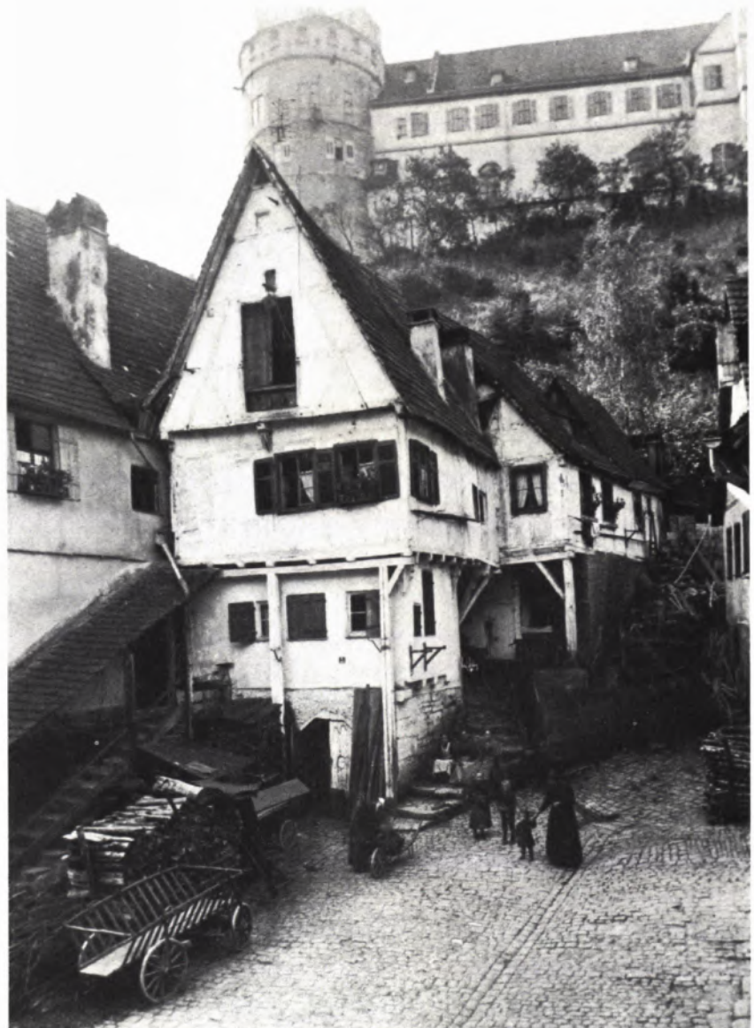
1 TÜBINGEN, HAUS HAAGGASSE 39. Alte Aufnahme des 1966 abgebrochenen Hauses. Am sehr steilen Giebel wird das übertünchte, verblattete Fachwerk des 15. Jahrhunderts sichtbar. Die beiden rückwärtigen, gestaffelten Giebel sind spätere Erweiterungen des Hauses. Zur Unterstützung der starken Auskragung des Obergeschosses wurde später ein „Bock“ untergestellt. Diese Hilfskonstruktion war vermutlich erst nach Ersetzen der leichten gestakten Riegelfelder durch Steine und Ziegel erforderlich geworden. Durch die Lage am Fuße des Schloßberges konnte bei diesem Haus im Sockelgeschoß ein gewölbter Keller errichtet werden.
