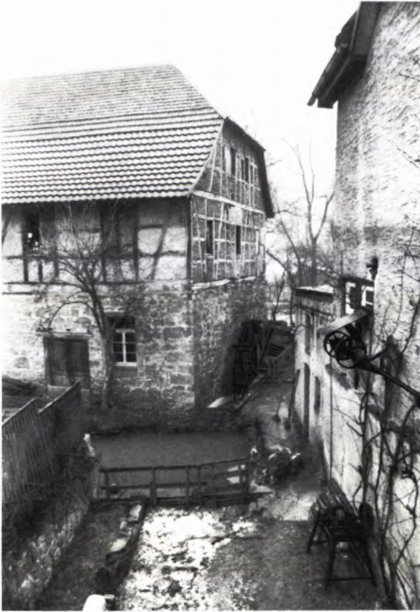
2 DER MÜHLKANAL vor dem Radstubeneinlauf; davon geht das Gerinne zum Wasserrad der Loh- und Ölmühle ab.
