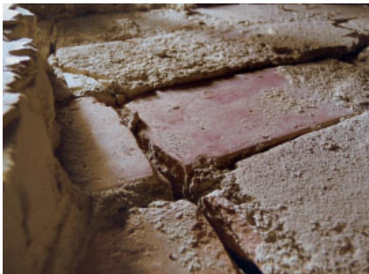
lich so pigmentiert, dass sich die Ergänzungen nach der Trocknung dem Umfeld angleichen und durch eine lasierende Farbbretusche ein ganzheitliches Erscheinungsbild erzielt werden konnte (Abb. 6). Weitere kleinere Risse wurden gewölbeunterseitig kraftschlüssig mit stuckverträglichem Mörtel geschlossen und an der Gewölbeoberseite mit Spezialmörtel injiziert.
