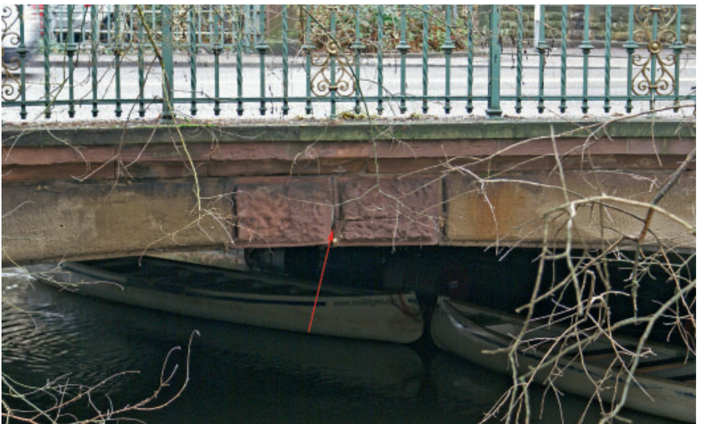
4 Scheitelgelenk der Hammerkanalbrücke.
