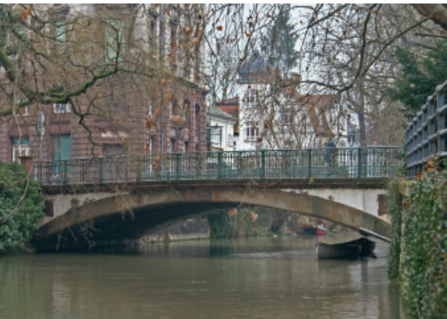
1 Die Brücke über den Hammerkanal in Esslingen.
