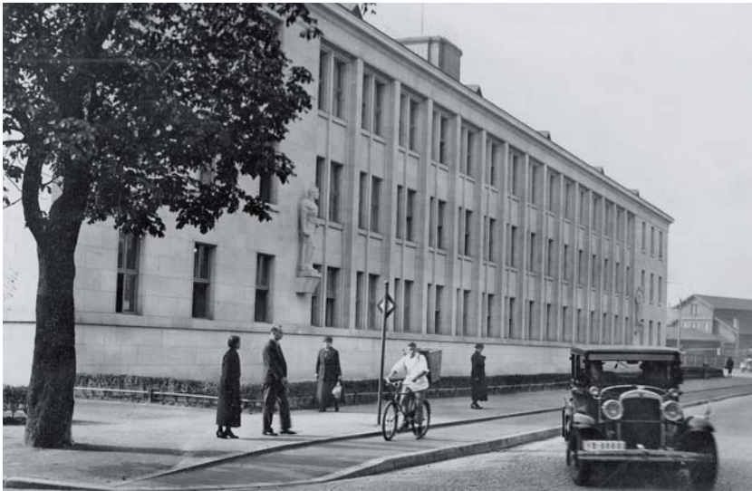
4 Straßenfassade, 1939 (Stadtarchiv Karlsruhe).
