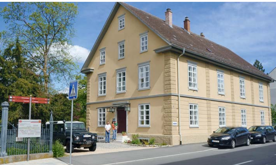
12 Das ehemalige Beamtenwohnhaus nach der Instandsetzung, authentisch bis ins Detail mit einem zukunftsfähigem Nutzungskonzept: repräsentative Räume im Erdgeschoss für eine Kanzlei und eine großzügige Wohnung im Obergeschoss. Vor dem Eingang: Preisträgerfamilie Förster.
