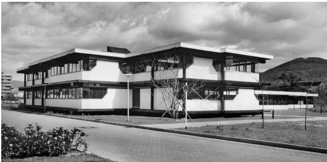
2 Durch die Aufständigung scheinen die Geschosse über dem Boden zu schweben. Die weißen Polygonkörper entfalten eine plastische Wirkung.
