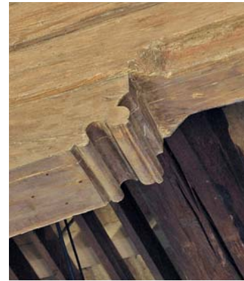
7 Mit gotischem Profil aus Birnstab und Kehlen verziertes Ende der Sattelhölzer im Obergeschoss.
