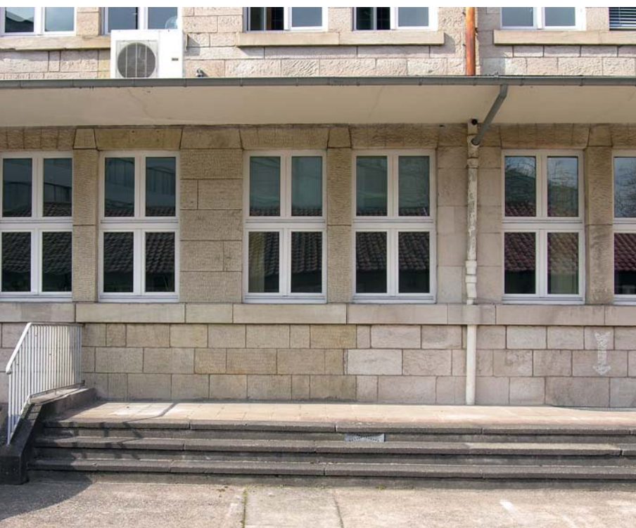
10 Vermauerte Öffnungen der Drehtüren.
