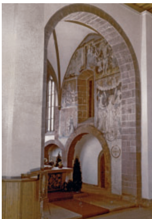
5 Blick in den Chor Richtung Südost nach Abschluss der Restaurierung und des Wiederaufbaus, 1954.
