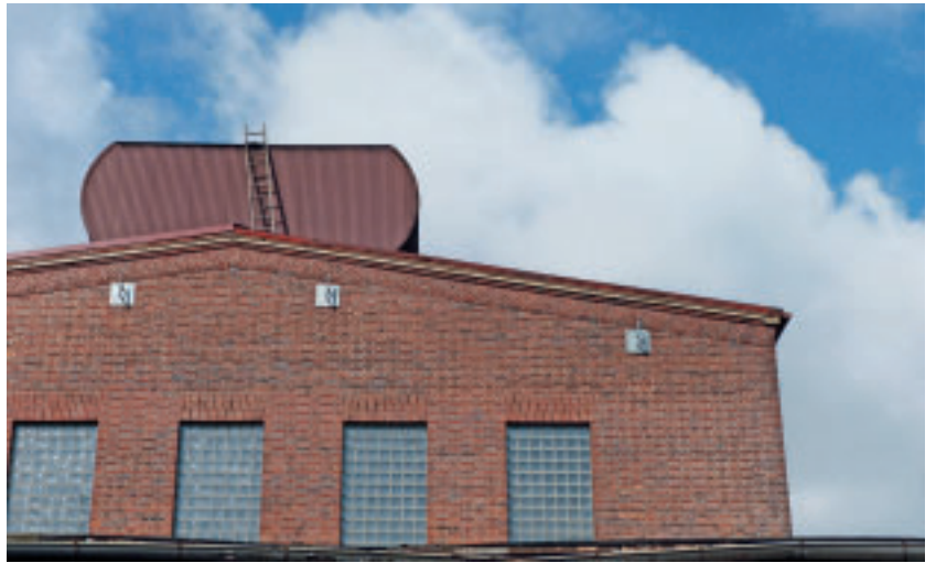
5 Ansicht der Gesenkschmiede III (auch „Neue Schmiedehalle“).
