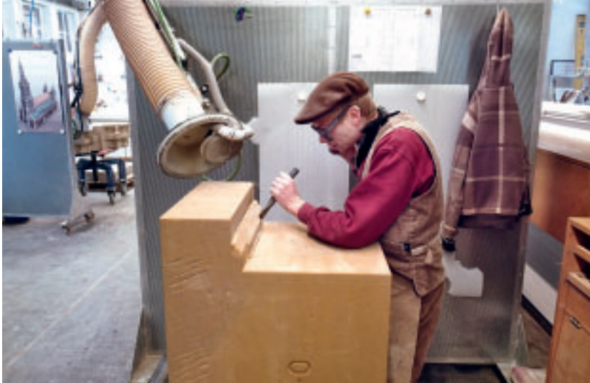
10 Fertigung eines Ersatzsteins für den Hauptturm aus Eisen-sandstein 2015.
