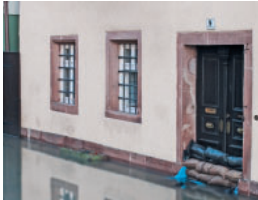
4 Sandsacksperrung beim Hochwasser in Wertheim 2011.
