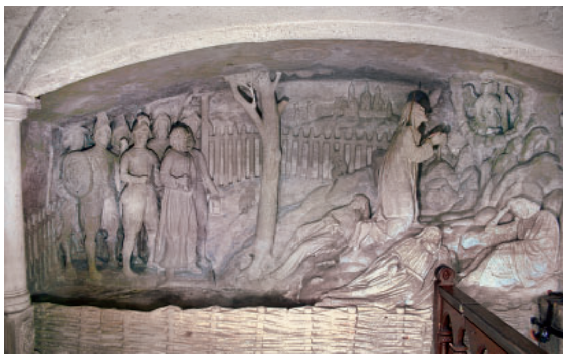
12 Gesamtansicht des Ölbergs nach der Konservierung.
