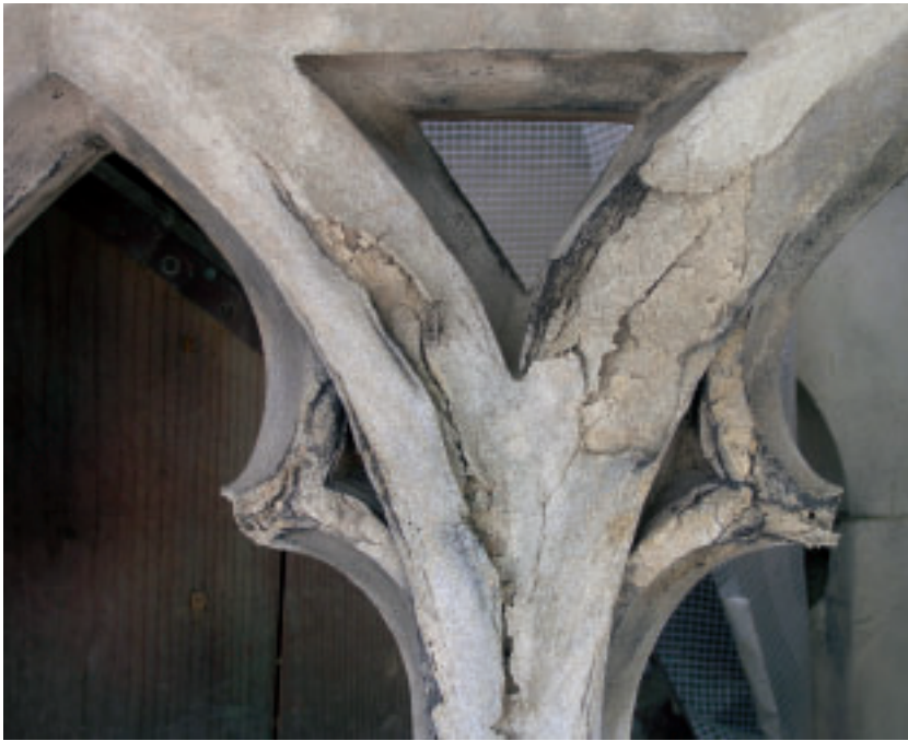
6 Detail aus dem Brüstungsmaßwerk am südlichen Chorturm, fortgeschrittene Schalenbildung, 2008.
