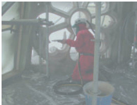
16 Eine anspruchsvolle, anstrengende Arbeit ist die Trockenreinigung mit feinstem Strahlmittel. Dabei trägt der Restaurator einen Schutzanzug mit Sauerstoffzufuhr und nimmt in einem Schutzzelt mit Absauganlage die Schmutzschicht von der Steinoberfläche.
