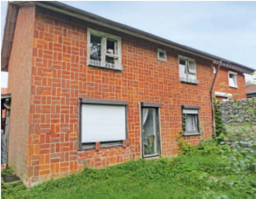
3 Aktuell fördert die Wüstenrot Stiftung in Baden-Württemberg die Instandsetzung eines Siedlerhauses von Egon Eiermann in Hettingen im Odenwald.
