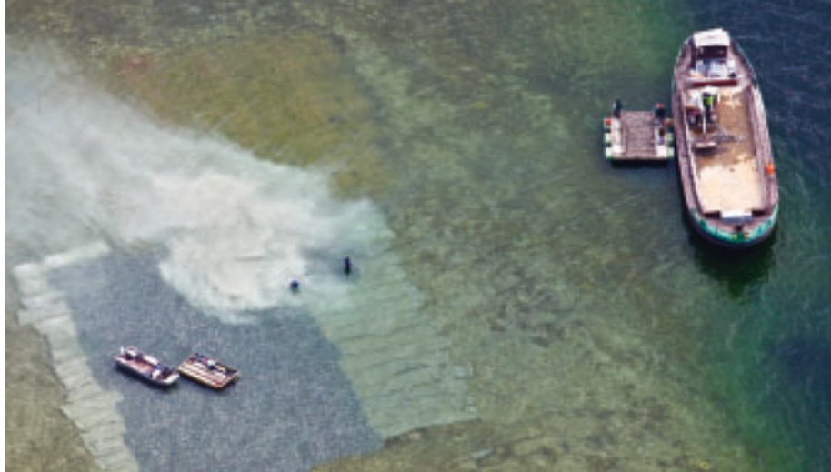
8 Einbau von Erosionsschutz in der Pfahlbausiedlung Sipplingen 2011.
