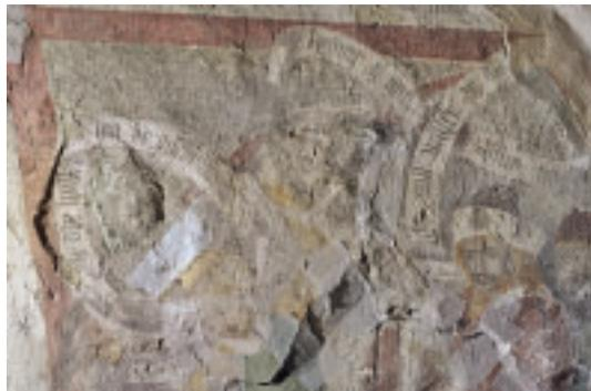
6 Detail der Chorsüd- wand im Streiflicht mit Notsicherungen in Form von Japanpapierkaschierungen im Bereich ab-sturzgefährdeter Putze.
