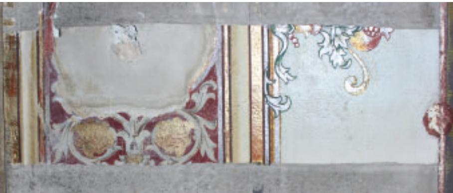
12 *Arbeitsprobe zur Malschichtfestigung, Vergleich Vor- und Nachzustand.*
