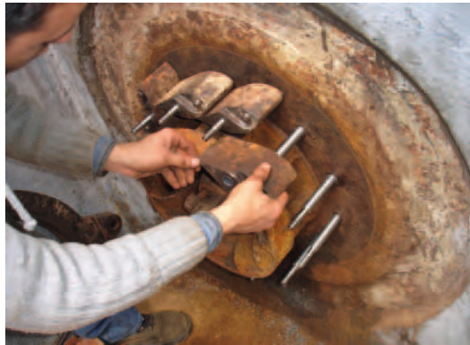
7 Neu angefertigte Achsbolzen, gereinigte Stellhebel und Leitschaufeln.
