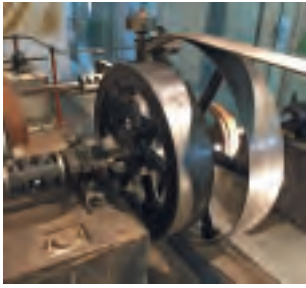
Historische Kraftwerkstechnik im alten E-Werk in Mössingen. Foto: Christoph Schairer
