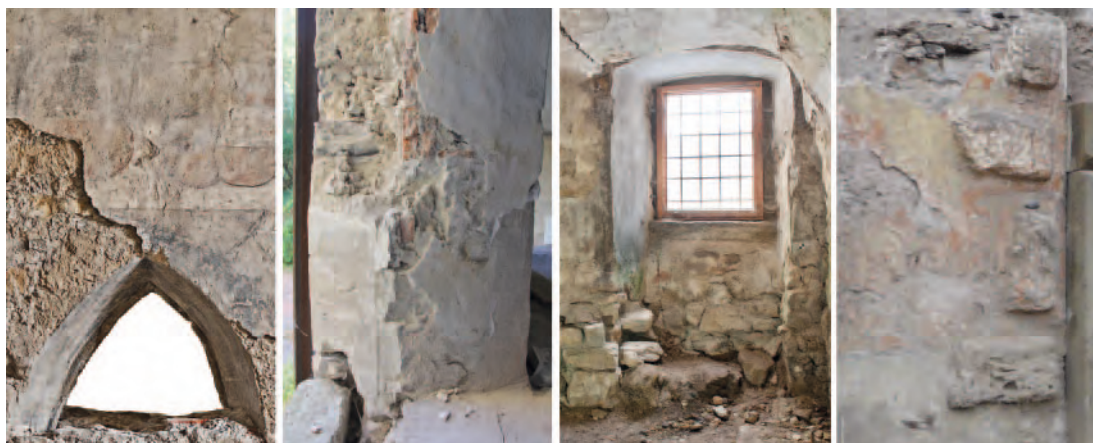
4a Das Spitzbogenfenster in der Nordwand der Kapelle.
