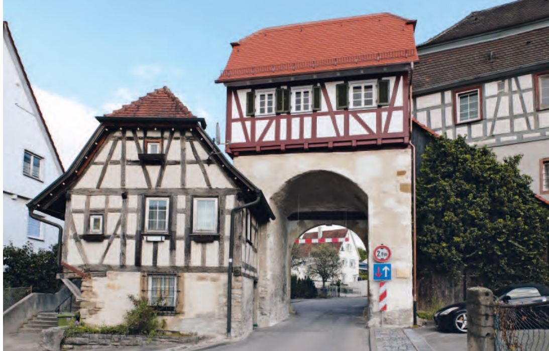
6 Ansicht des Grobbottwarer Tors von Westen (Stadtseite) nach der Sanierung.
