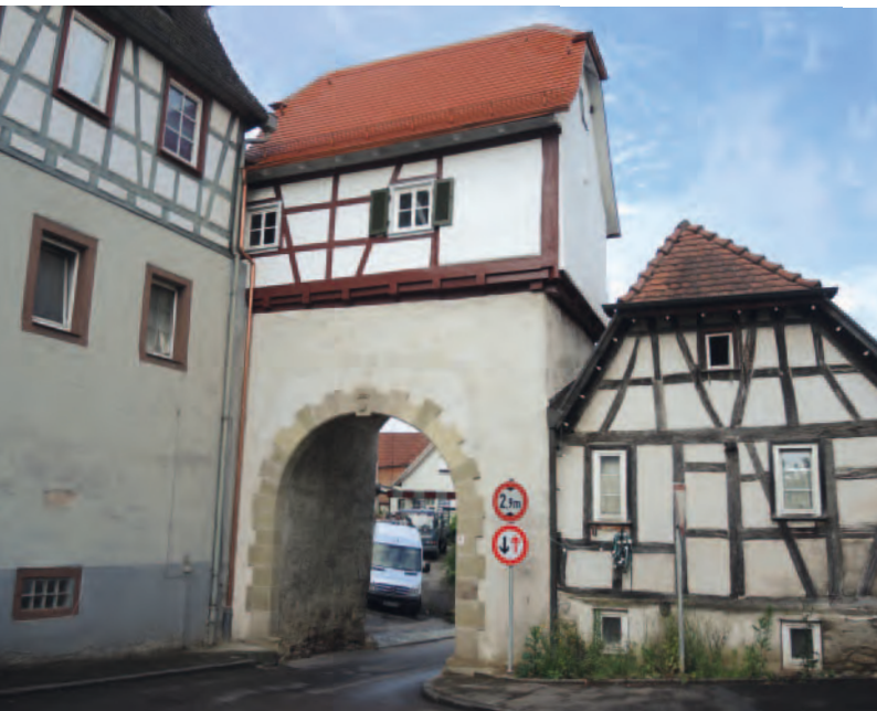
7 Ansicht des Großbottwarer Tors von Nordosten nach der Sanierung 2016.
