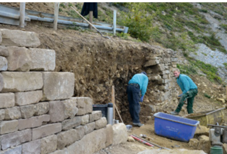
11 Neue, fachgerecht errichtete Trockenmauer im Weinberg bei Vaihingen-Roßwag
