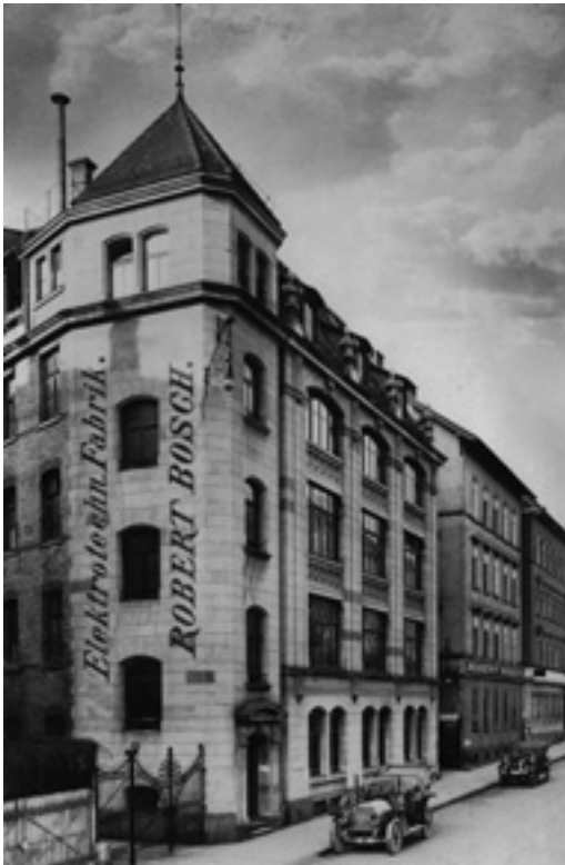
7 Erste Fabrik von Robert Bosch aus Eisenbeton und rechts eine Innenansicht aus dem Bosch-Areal mit Hennebique-Struktur.
