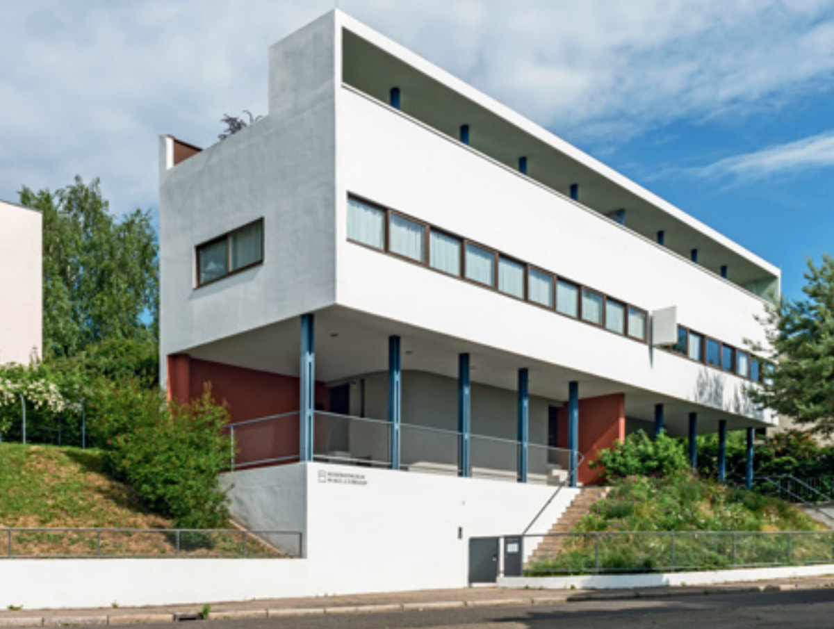
5 Doppelhaus von Le Corbusier und Pierre Jeanneret in Stuttgart von 1927.
