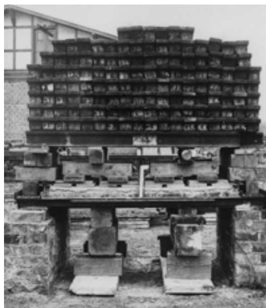
6 Belastungsprobe einer Decke.
