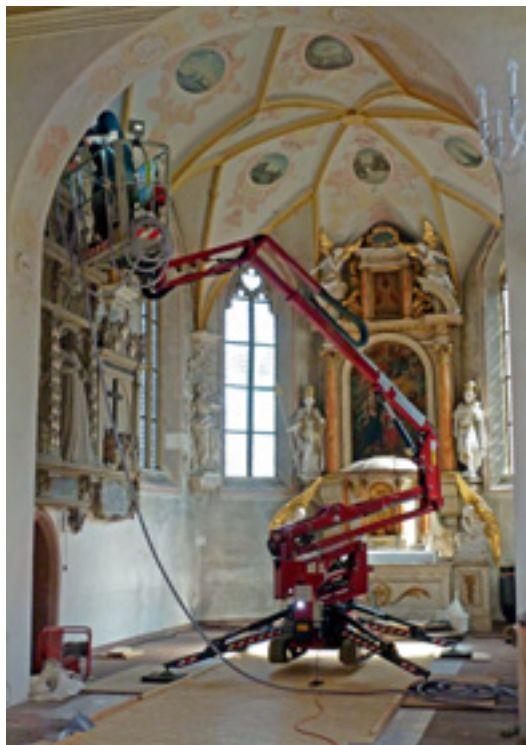
12 Restauratorische Strahlreinigung im Chor mit Latexgranulat vom Hubsteiger aus, 2016.
