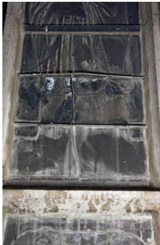
10 Innenseitige Wasserablaufspuren am Brenz-Fenster.
