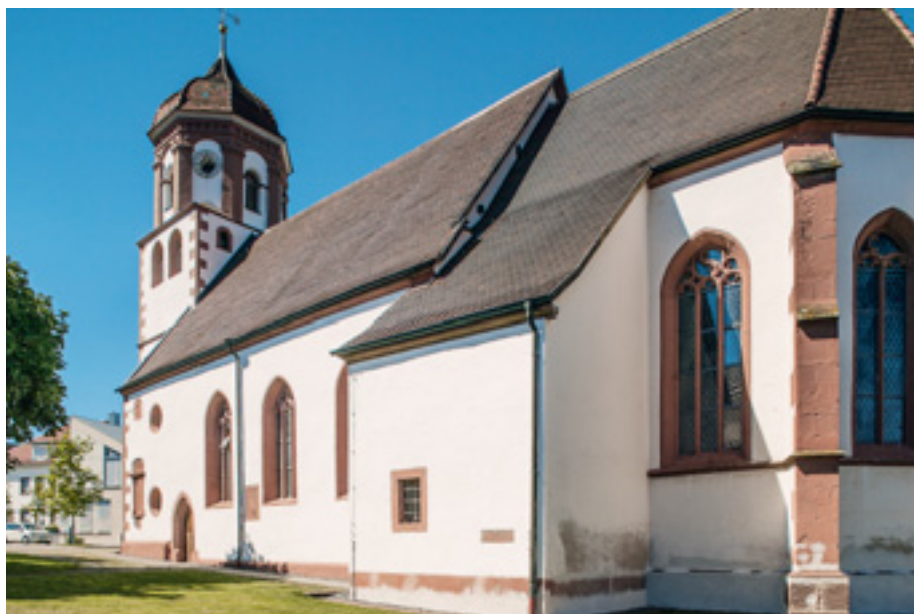
3 Chor und Südfassade.
