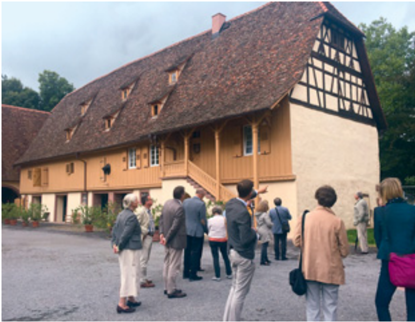
4 Im Hof von Schloss Königsbach informiert der Architekt Friedrich von Waldthausen über Details der aufwendigen Fassaden- und Dachrenovierung von Scheune und Meierei.
