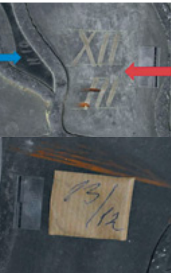
8 Fenster sII, Feld 7b: Oben: kleine Beschriftung „II 10“ (s. blauer Pfeil): eingebraunte Markierung, die auf mehreren Glasstücken zu finden sind. Große Beschriftung „XII III“ (s. roter Pfeil): vermutlich uneingebraunte Markierung. Unten: Beschriftung des letzten Ausbaus „13/12“ der 1960er Jahre.
