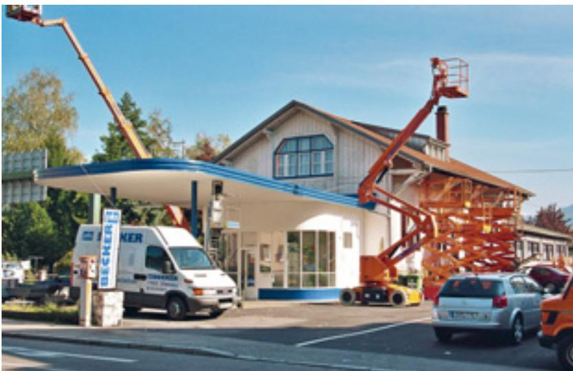
Vordächer ruhten auf einem filigranen Stützenpaar. Die Tankstelle in Offenburg wurde bereits 1950 von OLEX/Mannheim errichtet und kann als ein Vorläufer der später üblichen BP-Typen-Tankstelle „Bauform 52“ angesehen werden (Abb. 4). Der an ein bestehendes Gebäude angesetzte Tankkiosk besitzt allerdings, abweichend von der späteren Standardbauart, abgerundete Ecken, die sich am Vordach fortsetzen. Die hier vorhandenen dünnen Vordachstützen kamen auch bei späteren BP-Tankstellen vor.
