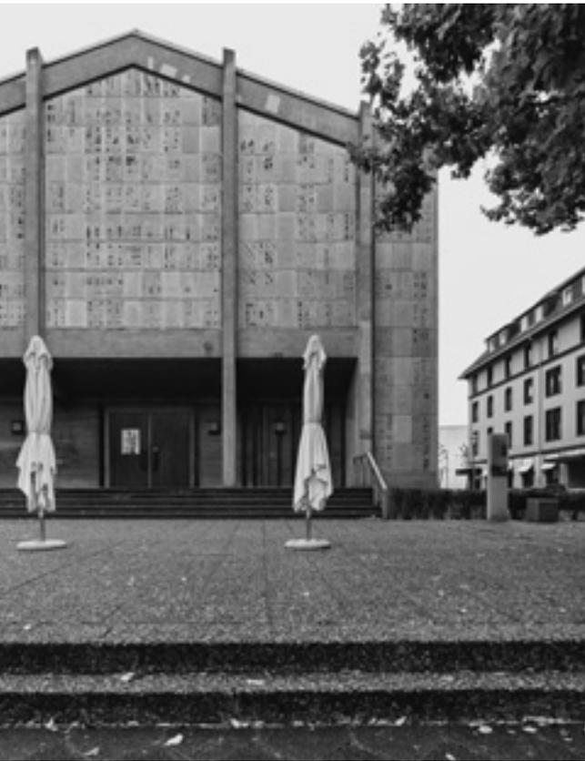
stück unterstützt wird. Dahinter steckt die Absicht des Architekten, inmitten des hektischen Stadtgeschehens einen Rückzugsort zu schaffen, an dem die Begegnung mit Gott und das Gebet möglich werden. Die Wände des Stahlbetonskeletts wurden sowohl im Innen- als auch im Außenbereich mit Betonformsteinen ausgefacht. Diese
