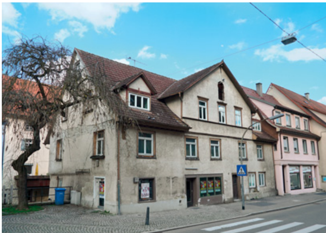
1 Das Gebäude Waldtorstraße 12 mit nur zwei Geschossen und breit gelagertem Quergiebel.
