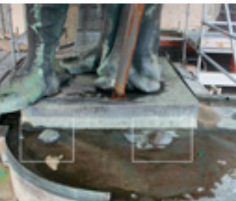
6 Die außerhalb der Figuren liegenden Schraubverbindungen sind mit großen kupfernen Hauerbuckeln abgedeckt (siehe Kästchen).
