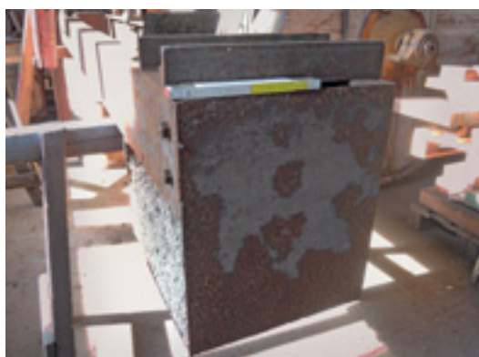
4 Die vorgefundenen Korrosionsschäden an der Waagkonstruktion waren zumeist nur oberflächlich, März 2017.
