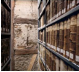
Stadtarchiv von Besigheim. Rollregale mit historischen Buchrücken und Fachwerkwand im Obergeschoss. Foto: RPS-LAD, Felix Pilz.
