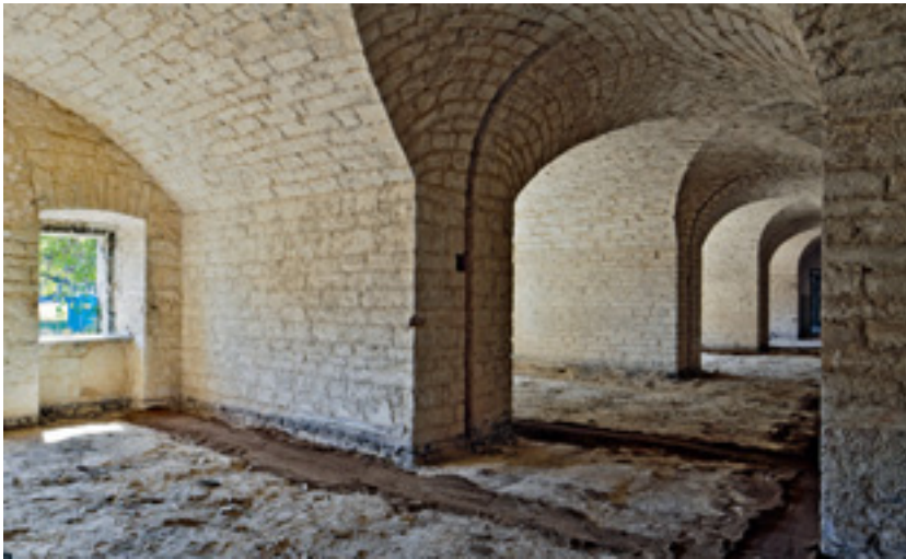
9 Die ehemaligen zum Innenhof hin ausgerichteten Wohnkasematten, hier im Zustand vor der Instandsetzung, reihen sich schier endlos aneinander.
