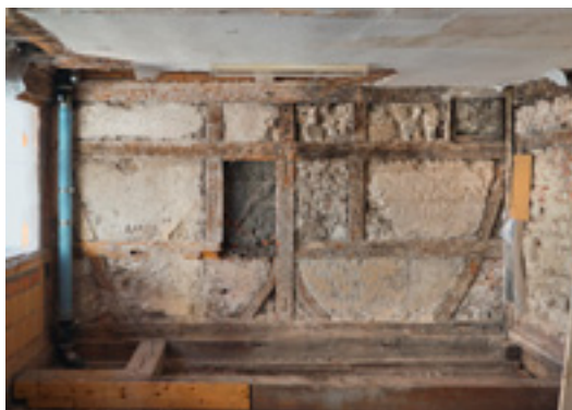
4 Das am vollständigsten erhaltene Teilstück des Fachwerkgerüsts im Obergeschoss mit früherem Doppelfenster, das durch anstoßende Gebäude vor Veränderungen bewahrt blieb.
