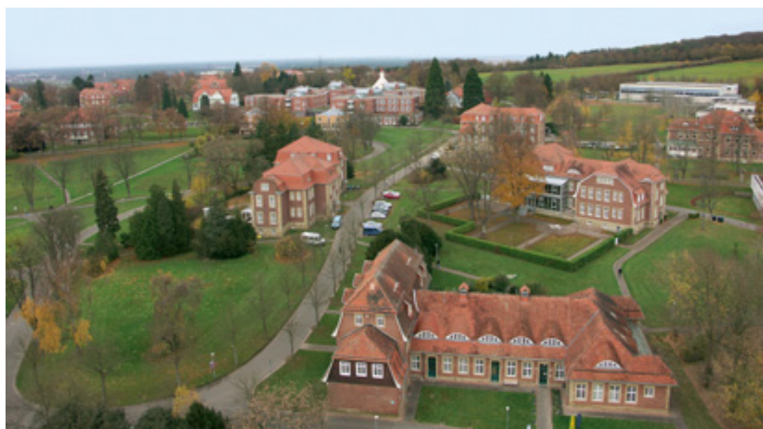
7 Krankengebäude für männliche Epileptiker ME und halbruhige Männer MH1, vorn das Werkstattegebäude, Aufnahme 2008.
