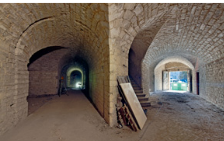
11 Derselbe Bereich nach Abschluss der Baumaßnahmen: Die Bruchsteinwände und -gewölbe erhielten eine Kalkschlämme, die Böden einen geglätteten Zementestrichbelag in Anlehnung an die dort bauzeitlich verlegten Kalksteinplatten. Durch die filigranen Glastrennwände bleiben die langen Flure erlebbar.
