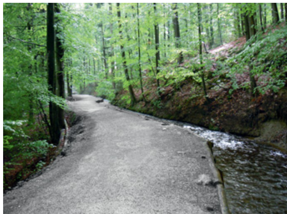
2 Wasser entlang des Steilhangs: die Hochtobeltrasse.
