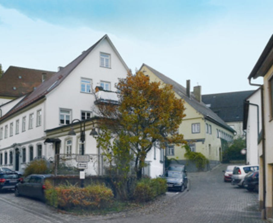
2 Blick in die Imhofstraße, den vormaligen Judenhof: Das Gebäude Imhofstraße 9 ist hinten links erkennbar, im Hintergrund das im 14. und 15. Jahrhundert mehrmals erwähnte Badehaus (Imhofstraße 17).
