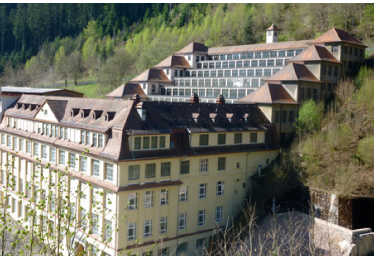
1 Der Terrassenbau ist in seiner ganzen Größe nur von erhöhtem Standort oder aus dem vorgelagerten Hauptgebäude zu sehen.
