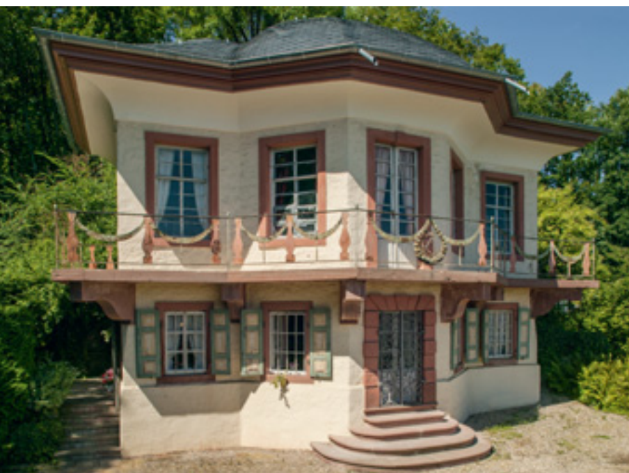
1 Mauer, Schlösschen „Sorgenfrei“, Ansicht von Nordost.
