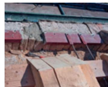
7 Additiv ergänzte Dachlattung mit unsichtbarer Sturmverklammerung.
