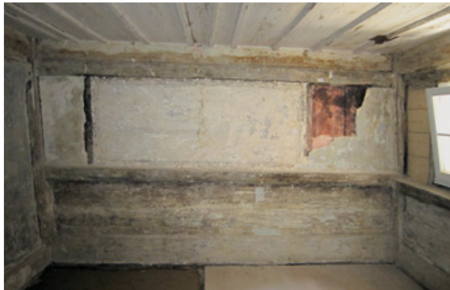
6a, 6b Gotische Stube im Rückgebäude vor und nach der Instandsetzung.
