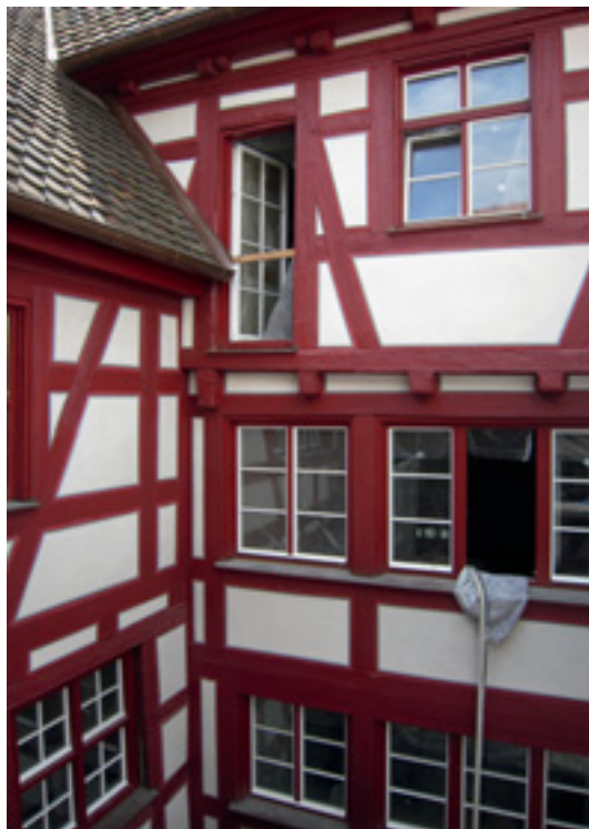
8 Innenhoffassaden in nach Befund kräftig rot gefasstem Sichtfachwerk.
