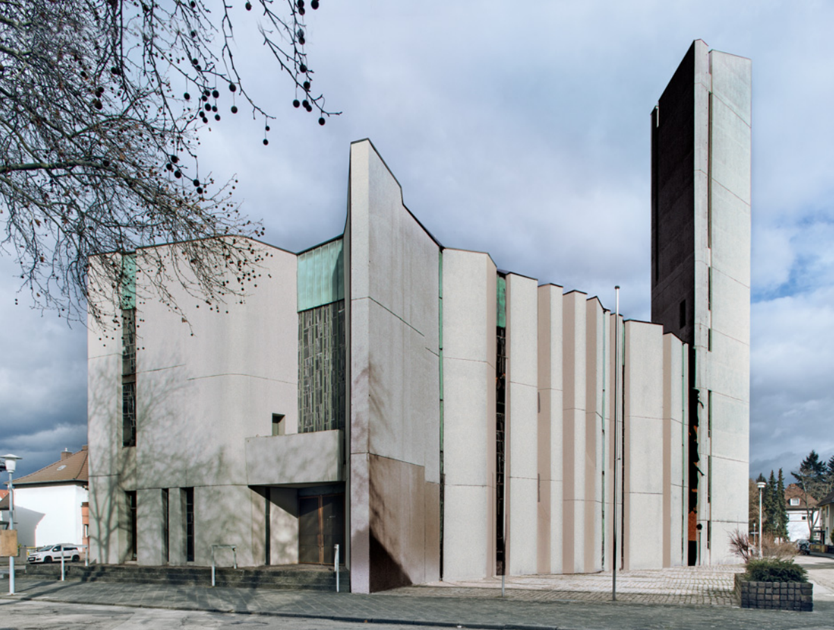
6 Mannheim-Rheinau, Versöhnungskirche. Eine zerklüftete Felswand oder ein Schutzwall aus Beton.
