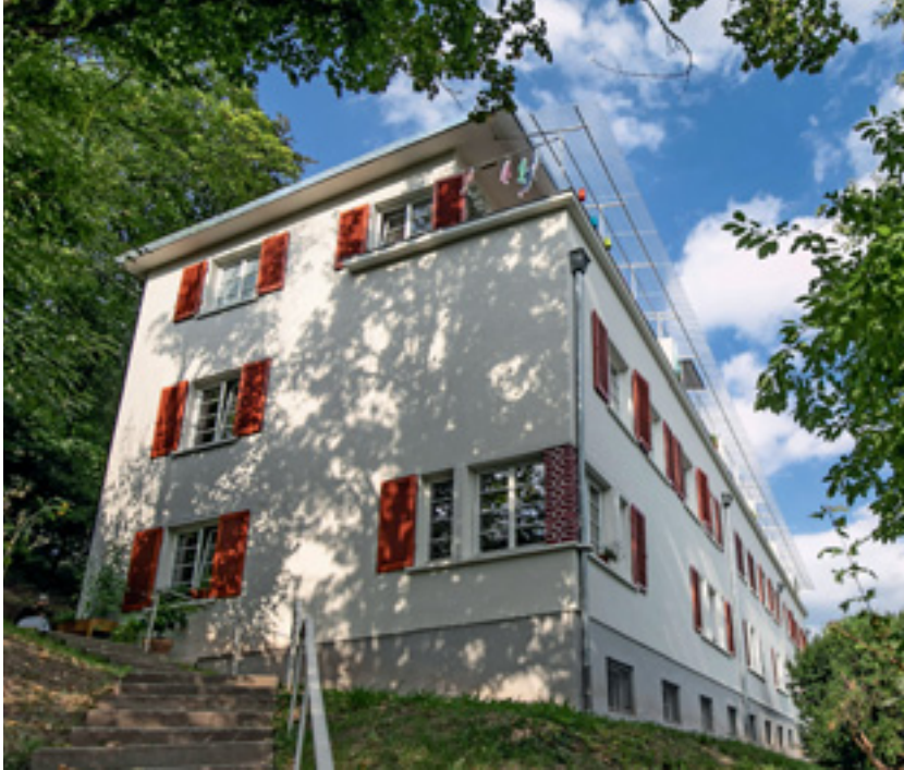
3 Ein Reihenhaus der 1928 erbauten Siedlung für Tuberkulosekranke in Stuttgart nach gelungener Instandsetzung.
