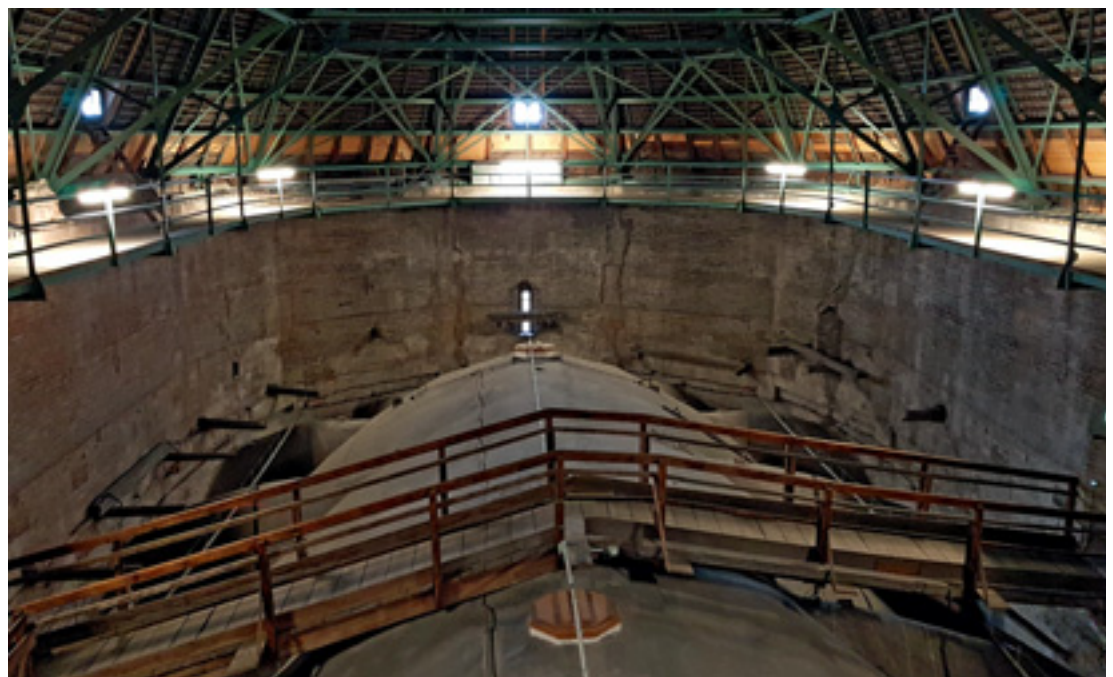
12 Über dem Chor des Ulmer Münsters spannt sich der filigrane Dachstuhl des Münsters. Nicht minder beeindruckend: die Gewölbekappen.
