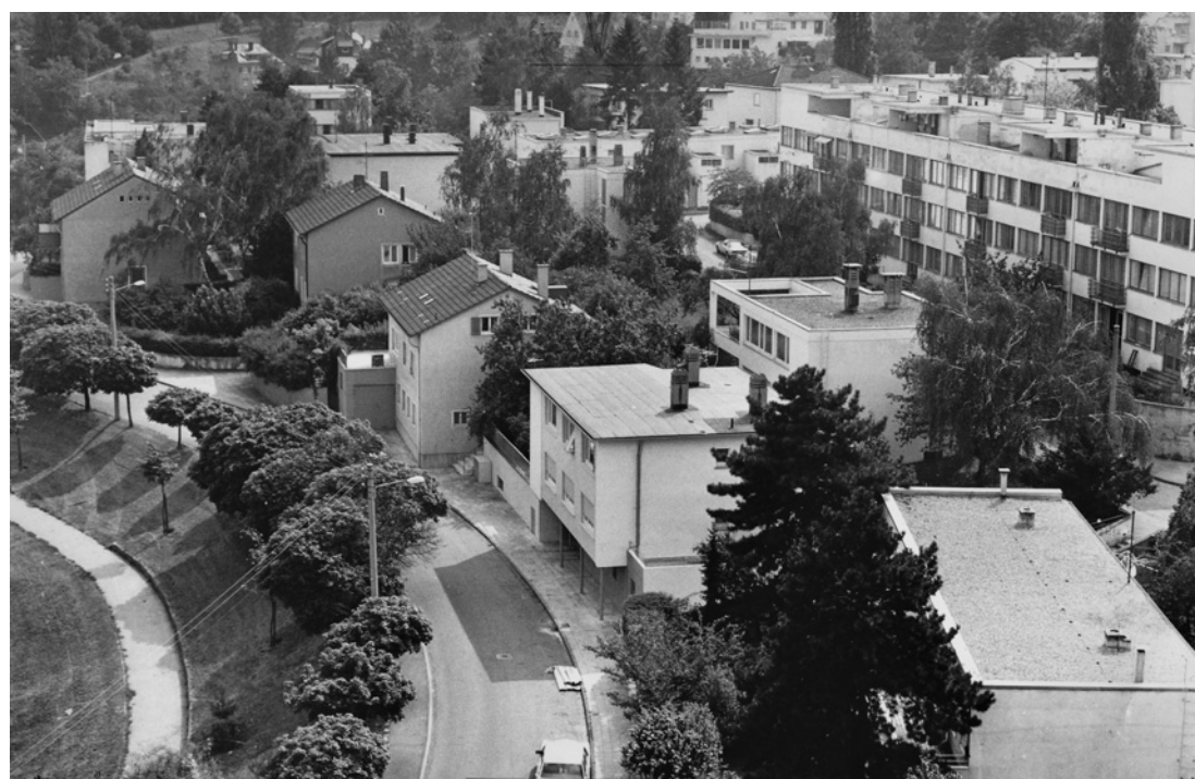
11 Blick auf die Ersatzbauten der ersten Phase mit Satteldächern in der linken Bildhälfte.
