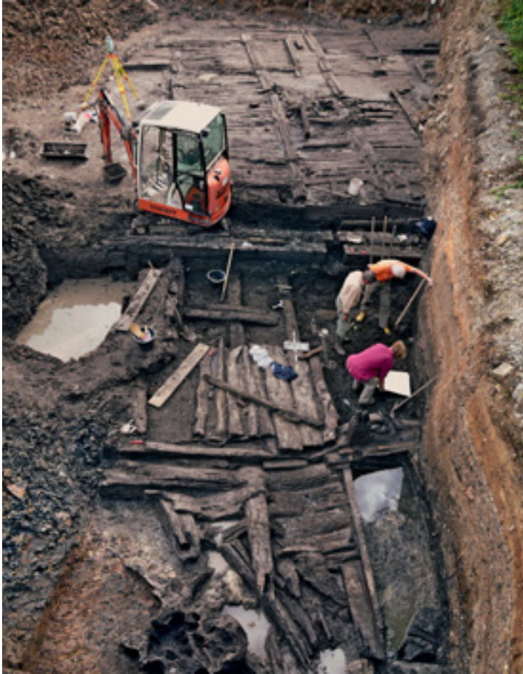
1 Im Vordergrund die Substruktion (Unterbau) des Gebäudes, dahinter (auf Höhe des Baggers) die Wasserrinne, dahinter die obere Lage der Straßensubstruktion.
