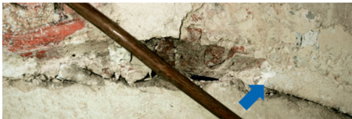
10 Teilweise offenliegender Chorbogen an der Ostwand. Im linken Bildteil ist die ursprüngliche Chorbogenausformung zu erkennen mit einem schräg in die Wand eingeschnittenen Bereich zwischen Bogenstirn und Bogenlaibung. Im rechten Bildteil ist die neue Bogenausformung der Phase 5 zu erkennen mit Vorritzungen und Armierung zum Auftrag eines Stucks.
