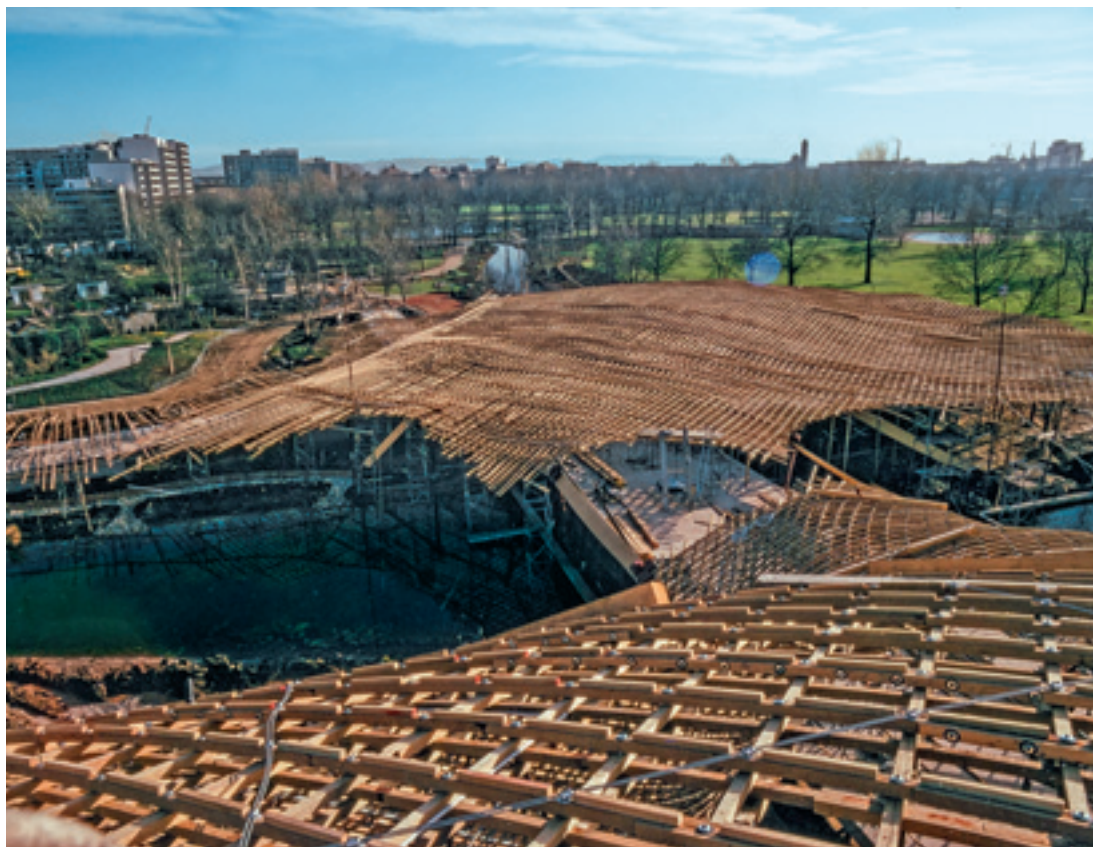
4 Die noch liegende Gitterschale der kleinen Halle 1974.
