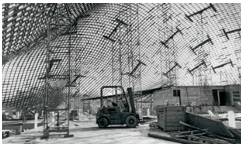
6 Belastungsversuch mit wassergefüllten Mülltonnen im Januar 1975.
