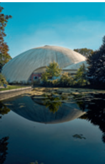
10 Organisch zwischen die Wasserläufe eingepasst, Aufnahme 2016.
