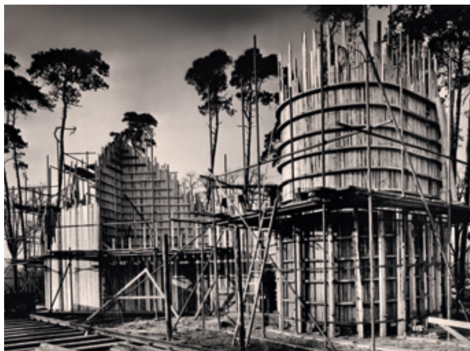
2 Betonierarbeiten der Blumenau-Kirche 1960: Aus einem Guss.
