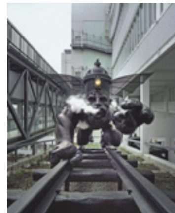
4 Stahlfachwerk. Brücke zwischen Kopf- und Ausstellungsbau.
