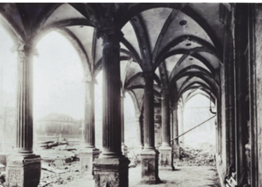
8 Nach dem Hoftheaterbrand aufgefundene Reste der Lusthaustreppe.
