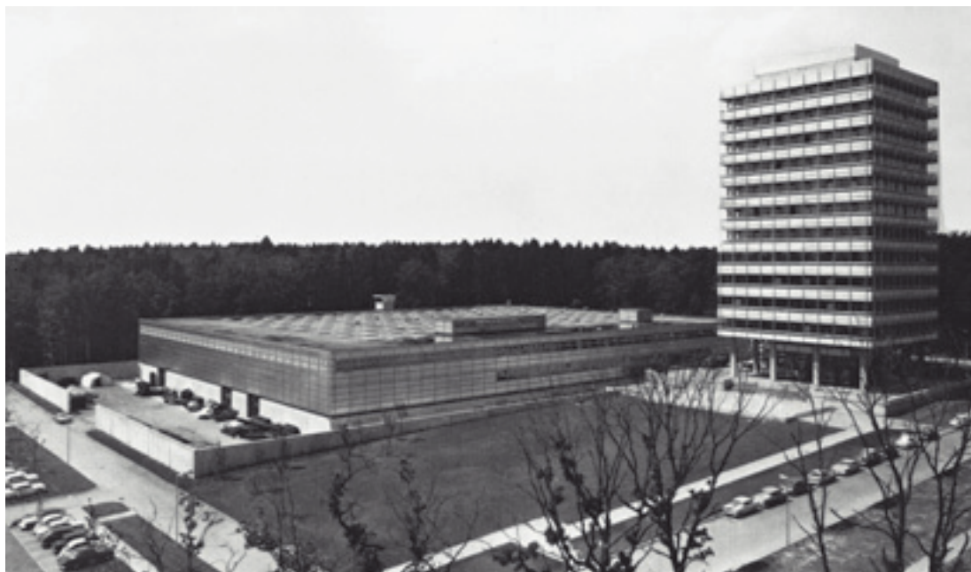
2 Gesamtkomplex der MPA nach Fertigstellung.
