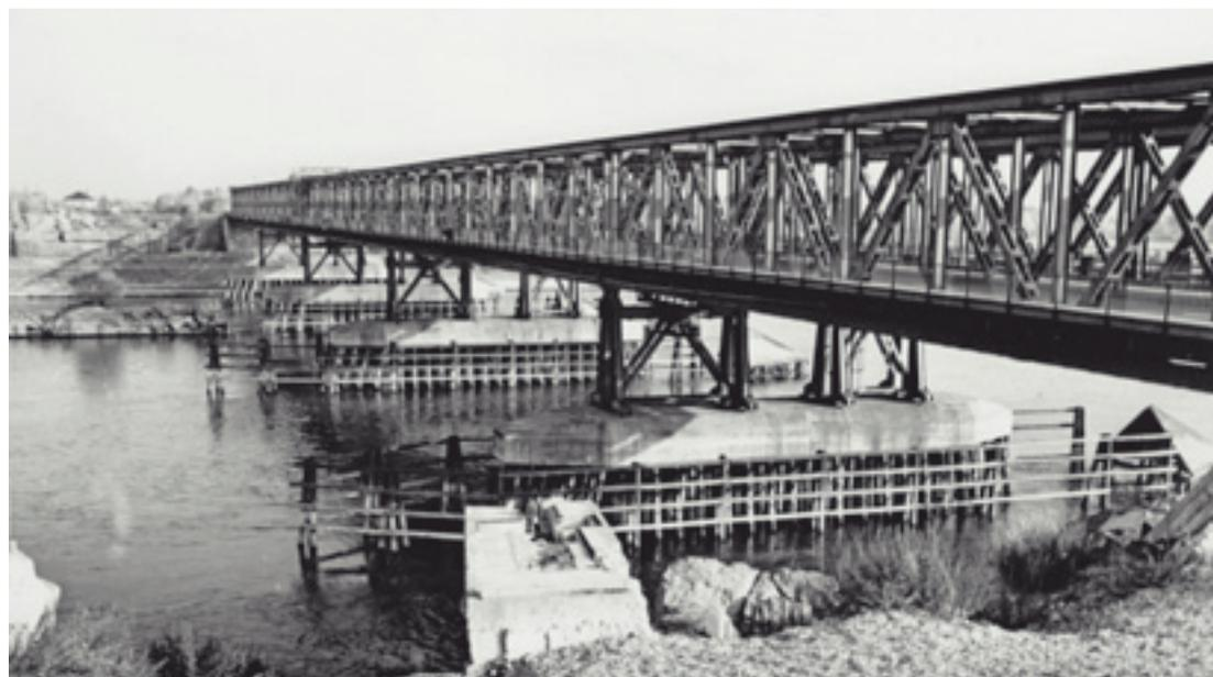
gerin wurde 1946/47 als Behelfs-Straßenbrücke aus alten Brückenteilen und diversem Brückengerät eingerichtet und stand bis 1962 (Abb. 12). Ab 1960 baute man anstelle der Behelfsbrücke eine neue stählerne Balkenbrücke, bei der die alten Pfeilergründungen genutzt werden konnten. Die nach Eröffnung des französischen Rheinseitenkanals überflüssig gewordenen westlichen Flutbrücken ersetzte man durch einen Damm – die Verkehrsfreigabe war am 1. Dezember 1962.
