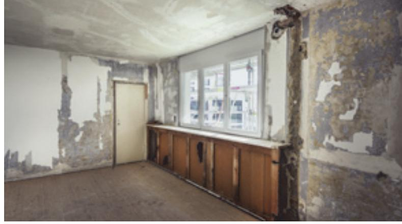
11–12 Die Schiebefensterkonstruktion konnte im Rahmen der Arbeiten an dem verborgenen, im Rahmen der Maßnahmen erhaltenen Fensterkasten nachvollzogen werden.
