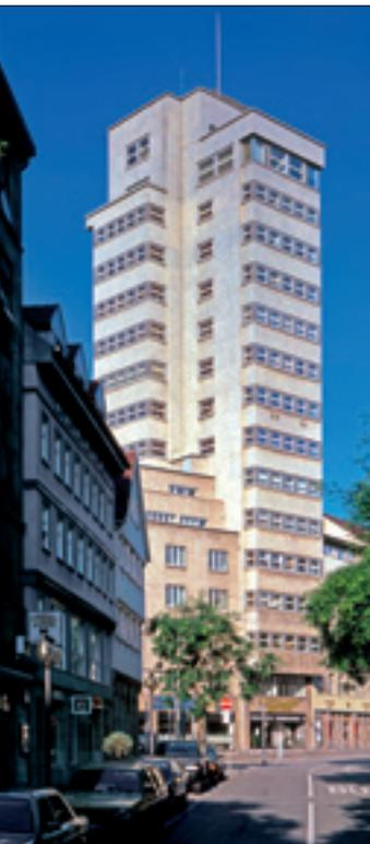
13 Der Tagblattturm nach Verputz der Fassaden und Entfernung der originalen Schiebefenster in den Jahren 1977/79, Zustand 1996.
