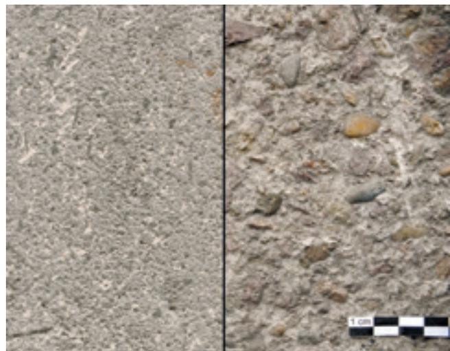
mäßigen Oberflächenbearbeitung mittels Stockeisen erkennbar. Im unteren Abschnitt wirkt der Beton hingegen grau. Die Oberflächenbeschaffenheit des hier sichtbaren Konstruktionsbetons wird durch das Schalbrettmuster und durch herstellungsbedingte Inhomogenitäten wie beispielsweise Kiesnester und Schüttlinien bestimmt. Abbildung 2 veranschaulicht deutlich die Herstellungsunterschiede zwischen dem bewusst gestalteten Sichtbeton und der baukonstruktiv entstandenen Betonoberfläche.
