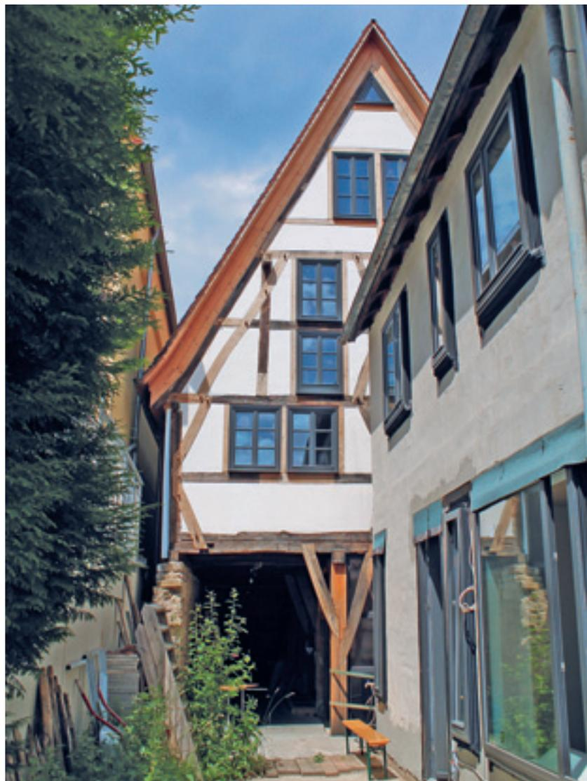
9 Das zweite Dachgeschoss mit dem in mittelalterlicher Zimmermannstechnik ergänzten Mittelunterzug. Zustand 2020.
