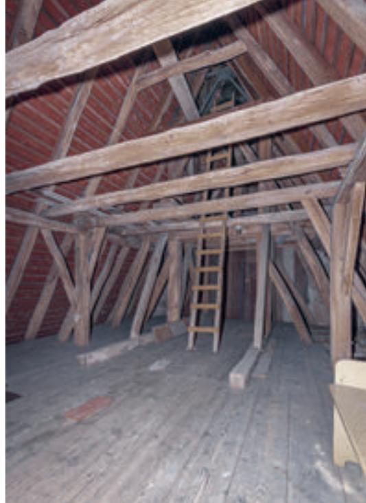
dachwerkes werden durch einen mittigen stehenden Stuhl unterstützt. Die Decken- und Kehlbalcken sind an die Sparren angeblattet.
