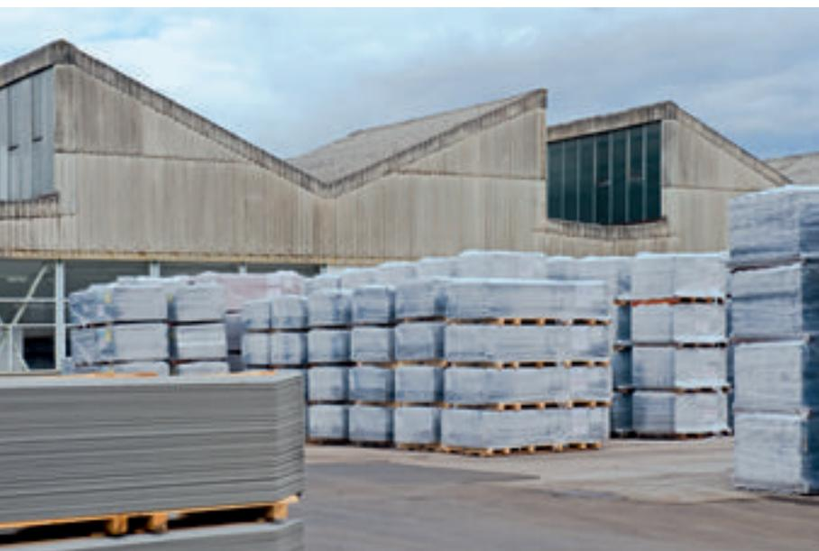
verschraubten Wellplatten erzeugt trotz des Auf und Ab der spitz zulaufenden Sheds eine geschlossene ruhige Form. Die vertikalen Rillen der Wellplatten sorgen für eine Belebung der großen Flächen, die je nach Lichteinfall hinsichtlich Tiefe und Schattenspiel differiert.
