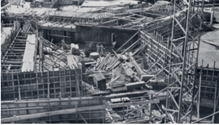
3 Brett-Kantholz-Methode für die geraden Wände – rechts im Bild der Mozartsaal.
