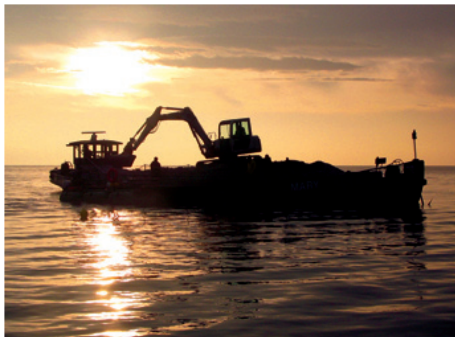
3 Denkmalpflegerische Schutzmaßnahme in Litzelstetten Krähenhorn 2009: Umladen von Kies für Schüttungen auf eine kleine Kiesschute.
