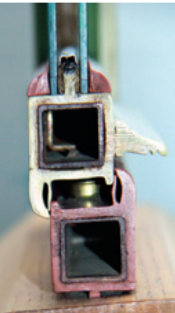
6 Isolierverglastes Kunststofffenster von 1954.
