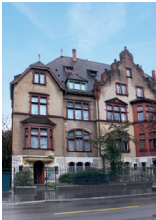
11 a–c Stadthaus in Basel. Detailansichten des fein profilierten Fenster- flügels von innen mit der 1969 eingesetzten Isolier- verglasung, von außen gehalten durch abgewin- kelte Aluminiumleisten.
