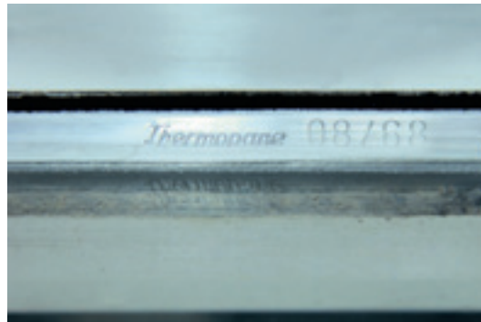
3 Isolierglas „Thermopane“ von 1968 mit gelötetem Randverbund (l. u.).
