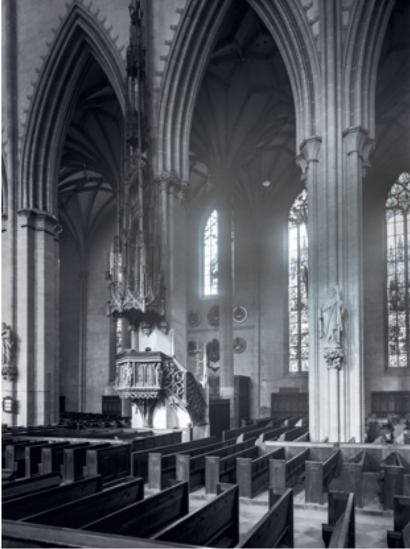
3 Historisches Foto der Vorkriegszeit, 1931: Blick vom Mittelschiff nach Nordwesten zum nördlichen Seitenschiff, ganz rechts angeschnitten das sogenannte Königsfenster, an dessen Stelle sich heute das Yelin-Fenster befindet.
