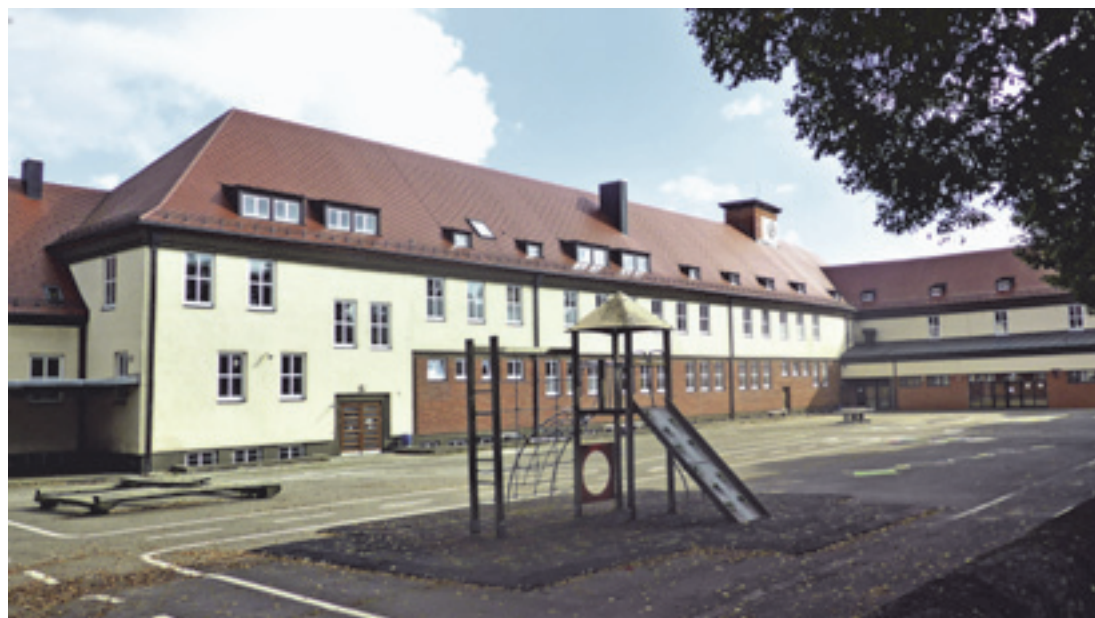
Ansicht des Schulhofs.
