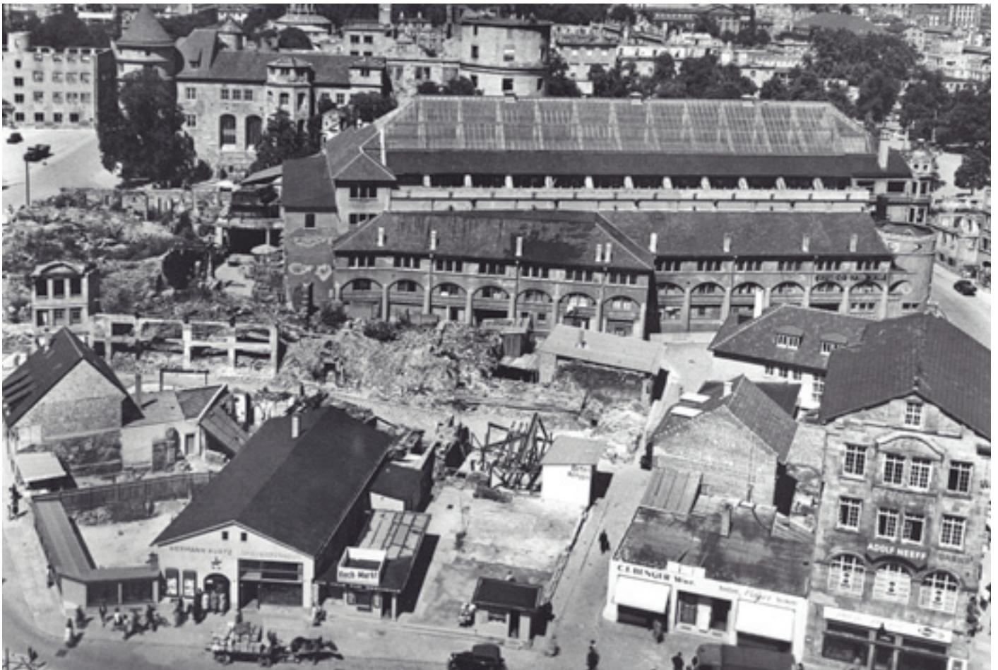
12 Die nach Kriegsschäden wieder hergestellte Markthalle, aufgenommen vom Turm des Rathauses, Zustand 1949.
