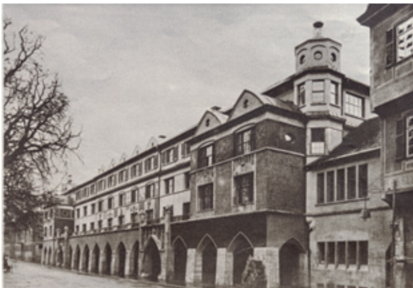
1 Die Markthalle, vom Schillerplatz gesehen, kurz nach ihrer Vollen- dung Anfang 1914 mit den noch 1913 geschaf- fenen kleinen Wandbil- dern über dem Terrassen- vorbau und am Stand- erker.
