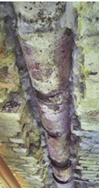
2 Eiserne Fallrohre mit Muffenverbindung.
