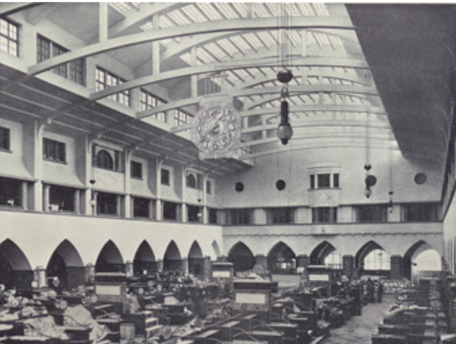
9 Die Halle von der Empore gesehen, Zustand 1914/15 mit der 1944 zerstörten Uhr.
