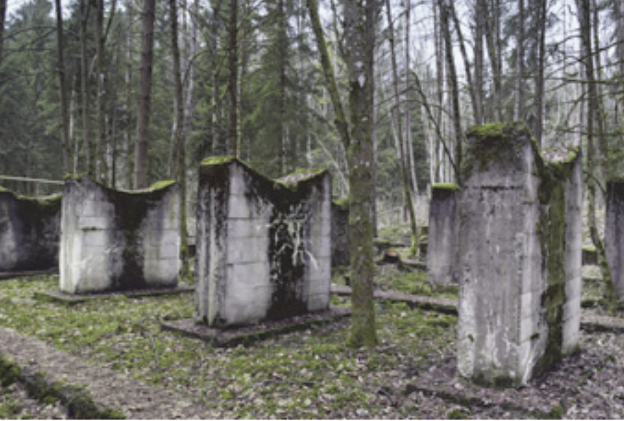
3 Betonruinen des Wüste-Werks 10 bei Zepfenhan/Gedenkstätte Eckerwald.
