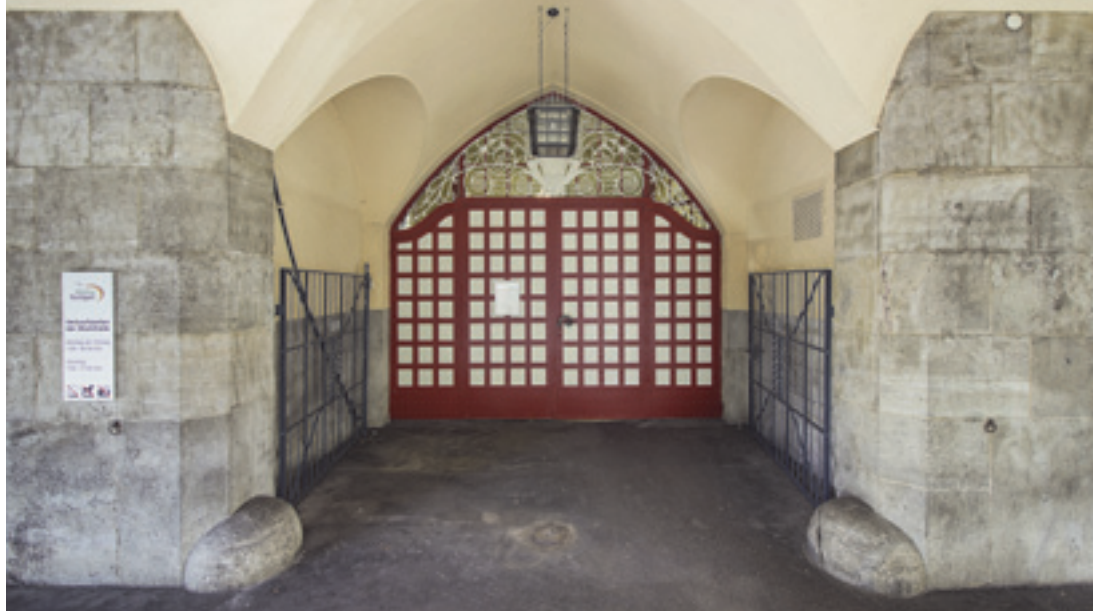
13 Eingang zur Markthalle vom Karlsplatz mit restauriertem und originalgetreu gestrichenem eisernem Torblatt, Zustand 2018.
