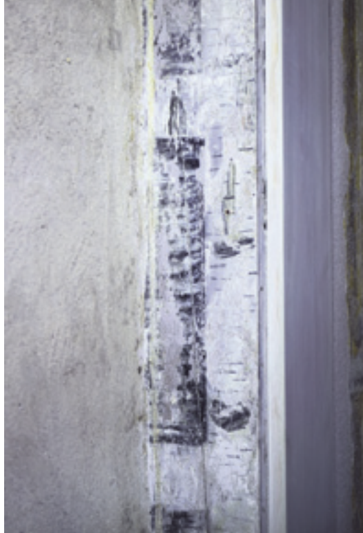
14 Detailaufnahme Endzustand, mit Putzergänzungen nur im Bereich originaler Freskoputzflächen mittels Strichretusche.
