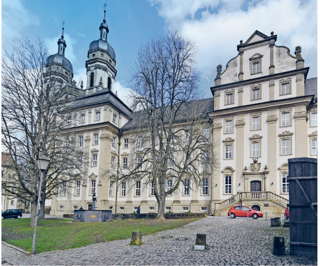
8 Blick von Westen auf den Mittelrisalit der Klosteranlage mit dem Treppenhaus.
