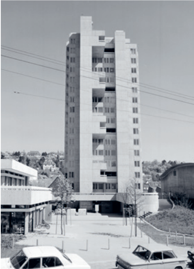
4 Gastdozentenwohnhaus mit integriertem Kindergarten und Vorplatz, links im Vordergrund Restaurant mit Clubhaus.
