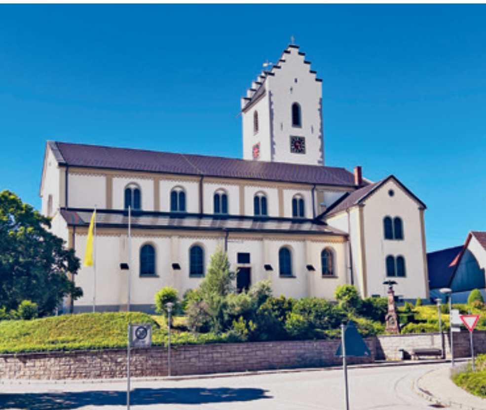
2 Bereits installierte PV-Anlage auf der Kirche St. Silvester in Emmingen.
