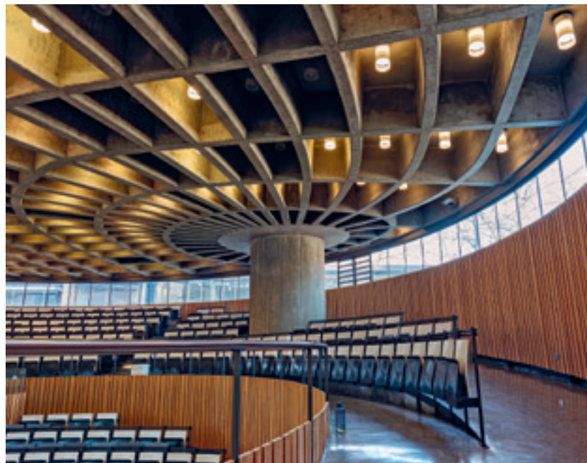
8 Hörsaalgebäude der Zoologie in Freiburg mit Rippendecke.
