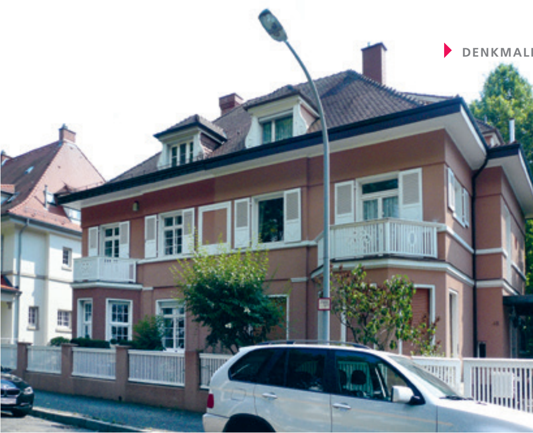
5 Mannheim, Paul-Martin-Ufer, Doppelwohnhaus mit Rollläden im Erd- und Klappläden im Obergeschoss, beides aus der Erbauungszeit. Die Rollläden verschwinden, wenn sie hochgezogen sind, vollständig in den Rollladenkästen.
