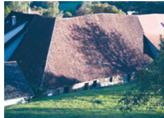
4 Klosterscheune Bebenhausen vom stark ansteigenden ehemaligen klösterlichen Obstgarten aus gesehen.
