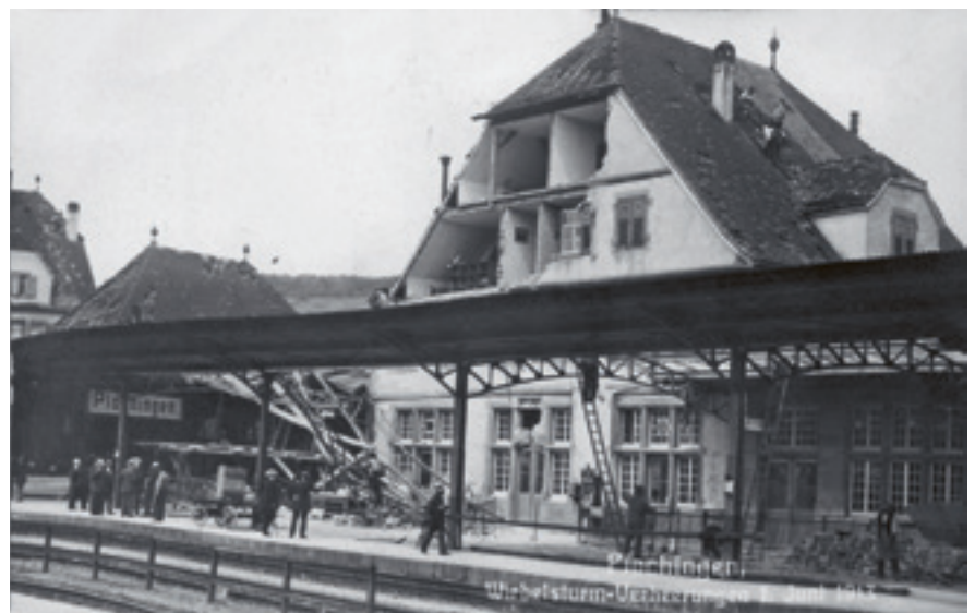
7 Schäden an der Westfassade des südlichen Kopfbaus und der Bahnsteigüberdachung nach dem Wirbelsturm am 1. Juni 1913. Dachdeckerarbeiten sind schon im Gange, Postkarte, 1913.
