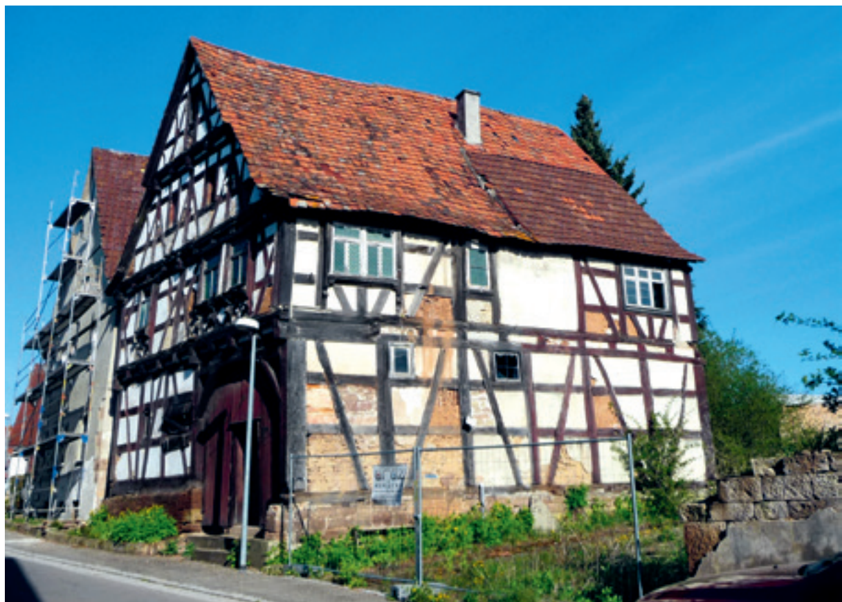
2 Gebäudezustand 2015, Ansicht Ostfassade.
