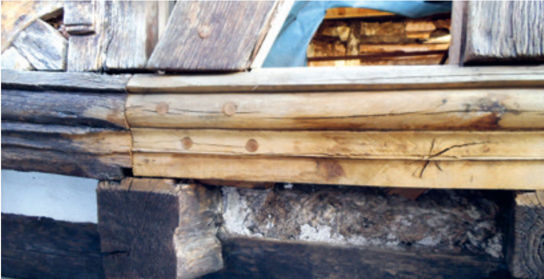
6 Reparatur der Schwellenprofilierung unterhalb der Fenstererker.
