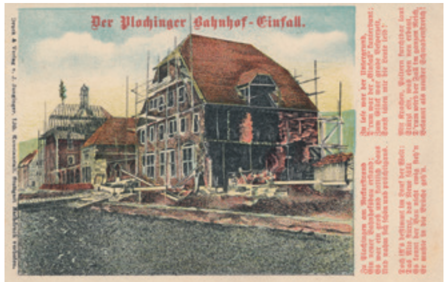
6 Teileinsturz der südlichen Fassade mit Spottgedicht. Postkarte, um 1906.
