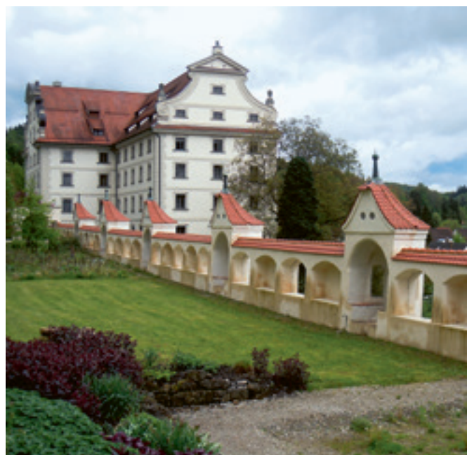
2 Von Martin abgeschaut? Schutzmauer in Martinsberg oberhalb der früheren Hanfhalde.
