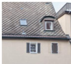
**8** Betondachsteindeckung in Esslingen von 1896.
