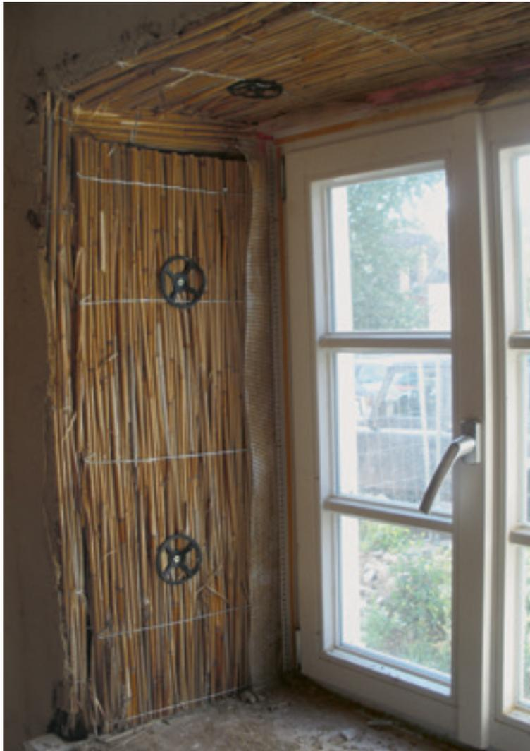
**6** Innendämmung aus Schilfrohmatten mit Lehmputz, 2014.
